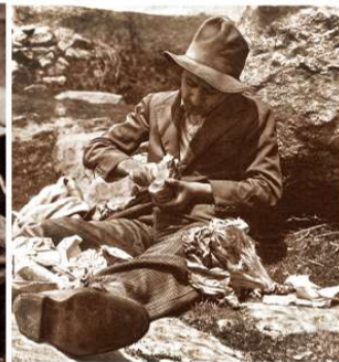
En la calle II.jpg
