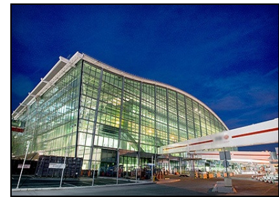
Londres-Heathrow. Terminal 5. Año 2008 http://www.transportplanning.mottmac.com/projects/termina5/
