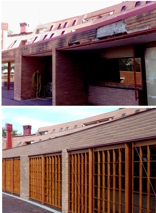
Figura 5. Galería antes (arriba) y después de la recuperación (abajo). Fuente: elaboración propia.
