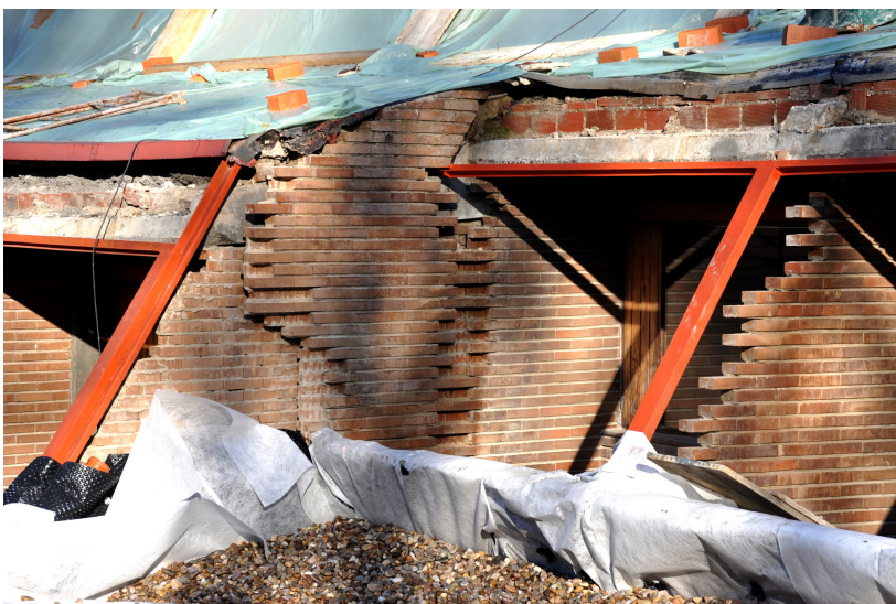
Figura 1. Vista de los paramentos de ladrillo separando las terrazas de las habitaciones durante la rehabilitación. Fuente: elaboración propia.
