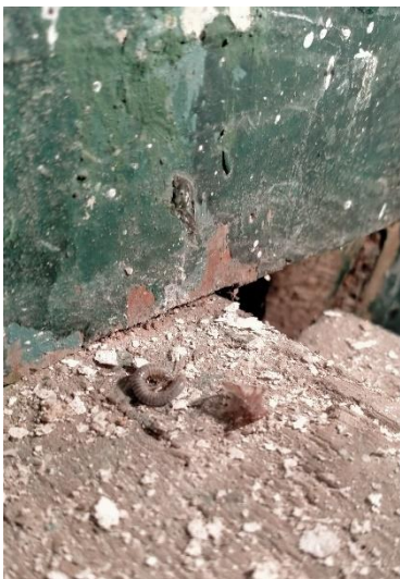
Fig. 16. Detalle de la suciedad del reverso del retablo del Perpetuo Socorro. Presencia de insectos. Fuente propia.
