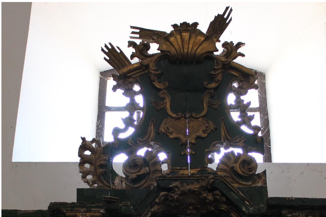
Fig. 20. Detalle del ático del retablo. Se aprecia la separación entre tablas por un anclaje deficiente, así como volúmenes perdidos o en proceso de perderse. Fuente propia.
