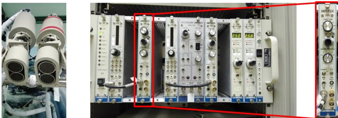
Figura 6.1: Detectores LEGe y cadena electrónica asociada, con el amplificador en la posición 10, que permite detectar en el rango de energía de 10-1000 keV.
