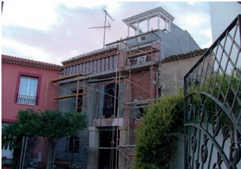
Obras de nueva edificación en calle Trinidad con Matadero. Uclés.
