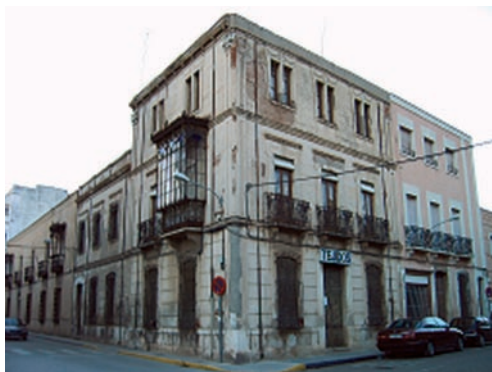
Fig 7: “Casa de las Telas”, en la que es manifiesto el evidente estado de abandono en que se encuentra. Incluida en el Catálogo de 1979.
