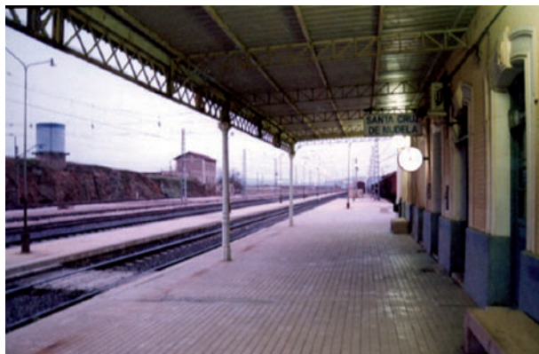
Aspecto actual del andén de la estación de Santa Cruz de Mudela.
