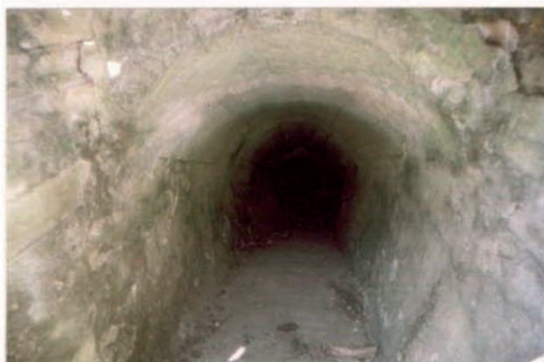
Boca de entrada del agua.
