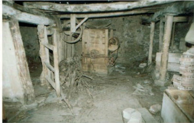
Vestíbulo del molino.
