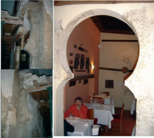
Lámina 4: Arco de herradura documentado en el extremo oeste de la crujía sur (izda. arriba y abajo). Arco de herradura documentado en la crujía sur de la Casa del Temple (dcha.). (fotos: A. Lavesa)
