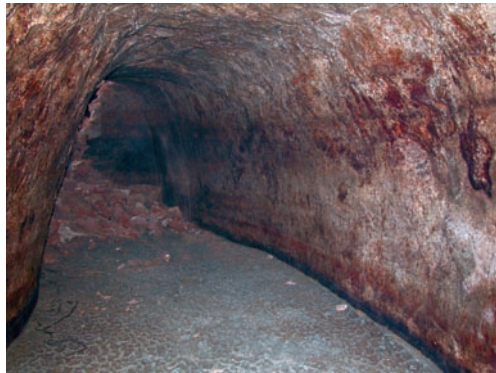
Fig. 2.- Galería 1, tramo “a”.
