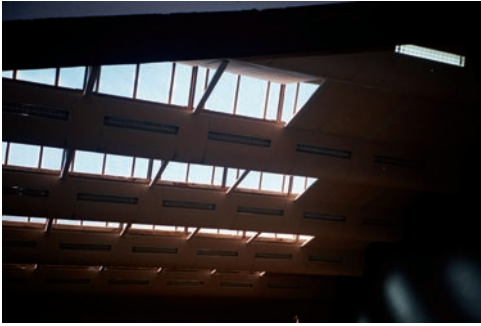
Figura 1. Detalle del techo del Salón de Actos.
