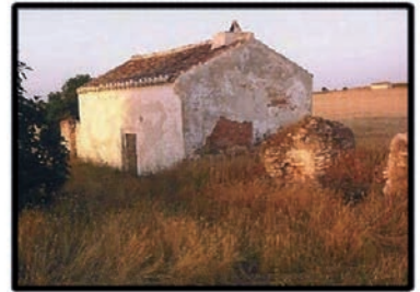
Abandono y deterioro...
