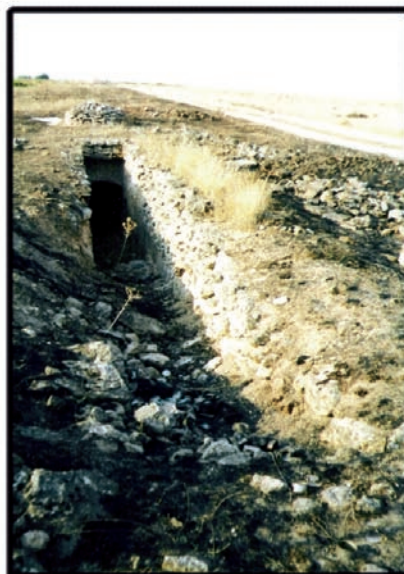
Cañada muy deteriorada.
