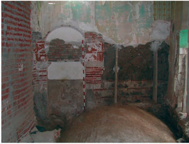
Fig. 1- Arco islámico y paramento asociado tras el rebaje del muro. Se han destrozado las jambas, así como los cimacios, revocos, etc.
