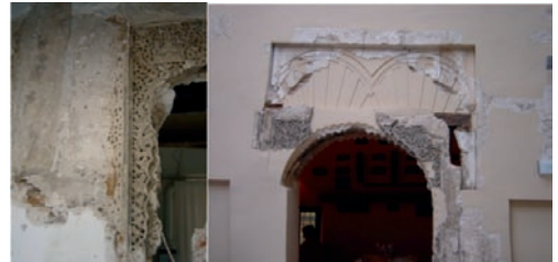
Lámina 3: Arco de herradura andalusí amortizado por el de yeso (izda.). Arco documentado en la crujía este de la Casa del Temple (dcha.). (fotos: A. Lavesa)
