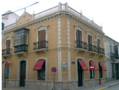
Fig. 4: Casa situada en c/ Seis de Junio, esquina B. Balbuena, en la que se ha actuado recientemente en su recuperación y rehabilitación.
