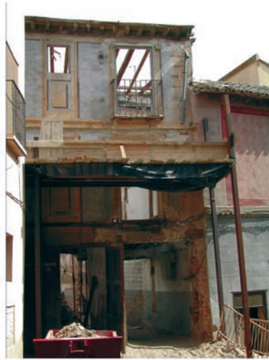
Fig. 3- Fachada original. Desaparecida.
