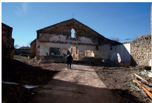
Lám. IV: Estado actual del pósito de Sigüenza, futura sede del centro de interpretación de la ciudad.
