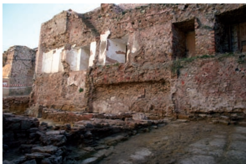
Lám. III: Vista general de la muralla del S. XIV que próximamente será objeto de musealización dentro de la ruta “Sigüenza Arqueológica”.
