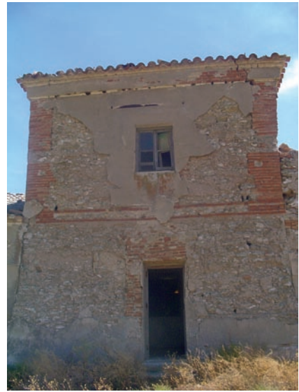
Fig. 3: Casa del Telégrafo, en Aranjuez (Madrid).
