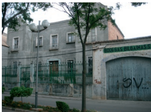
Fig. 3: Fachada de la casa perteneciente a las antiguas Bodegas Bilbaínas, en la que se puede observar el deterioro tanto de la propia edificación como del entorno. Actualmente restaurada.
