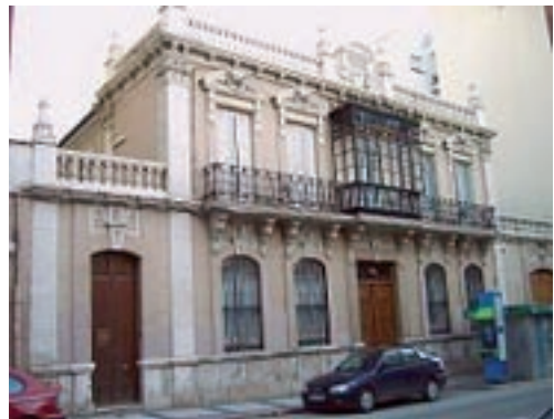
Fig. 2: Fachada actual de la Casa Cruz, situada en c/ Seis de Junio
