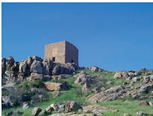
Fig. 5: Torre telegráfica del cerro de Santa Ana, en Puertollano (Ciudad Real).
