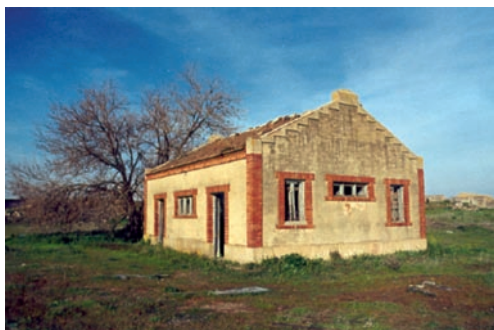
Lampistería de la estación de Santa Cruz.
