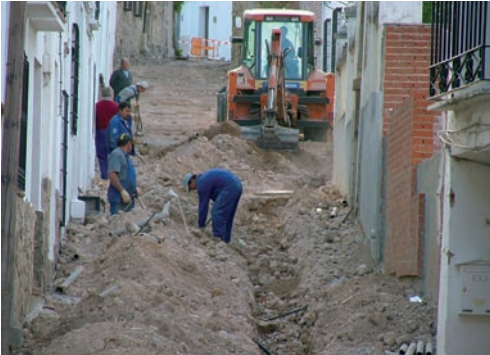
Obras de acondicionamiento canalización y saneamiento soterrado en calle Angustias. Uclés.
