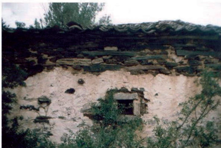
Detalle de la fachada posterior.
