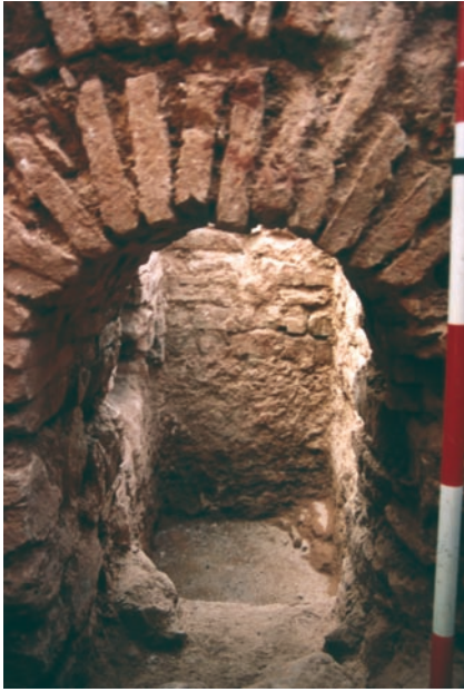
Detalle del acceso a la cámara de la Tumba 1.
