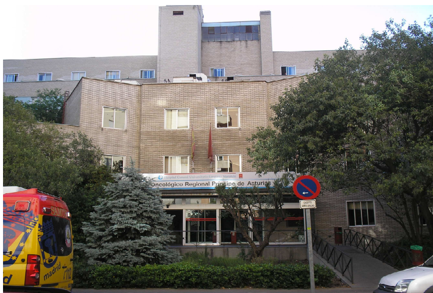
Figura 23. Fachada del pabellón de Oncología del HGUGM
