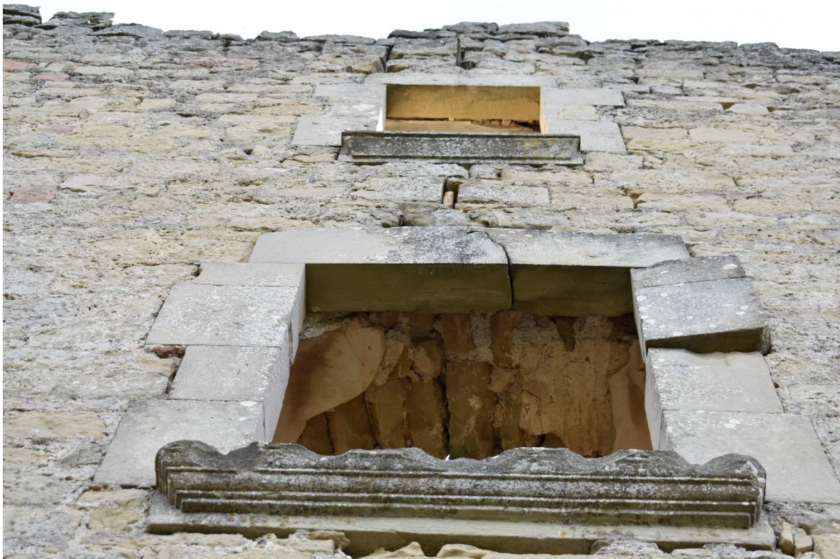
Figura 43. Detalle de las ventanas de la fachada norte en la torre del homenaje (2023). Fuente: propia.
