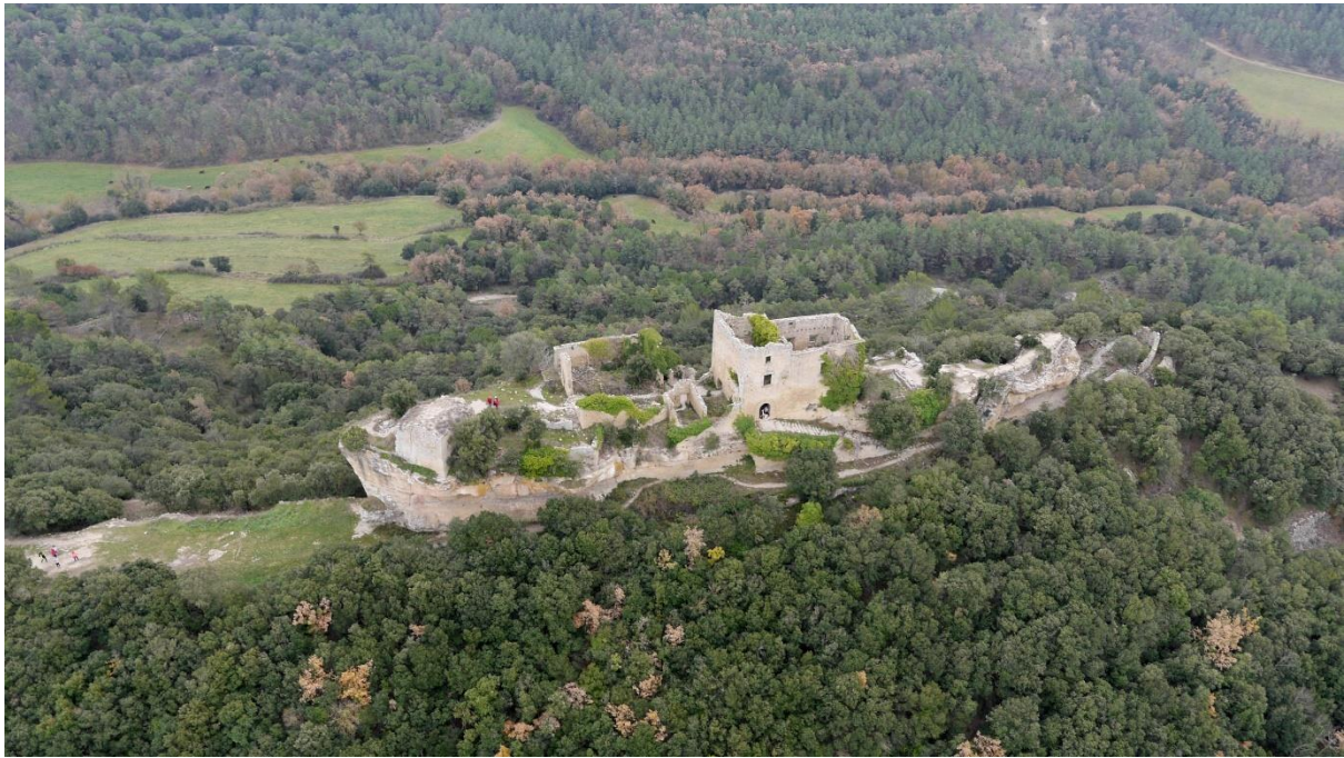
Figura 26. Vista aérea del perfil norte del conjunto del Castell de la Popa (2017) (Agents Rurals, 2017).
