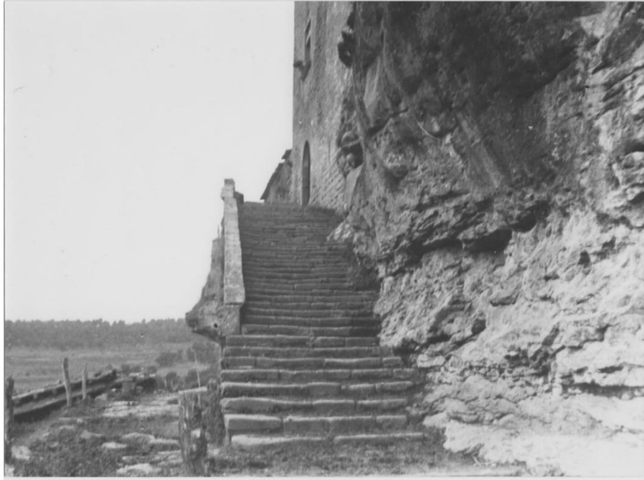
Figura 6. Escalera de la entrada con la barandilla en buen estado de conservación (1921). Fuente: imagen cedida por Axel Torelló.
