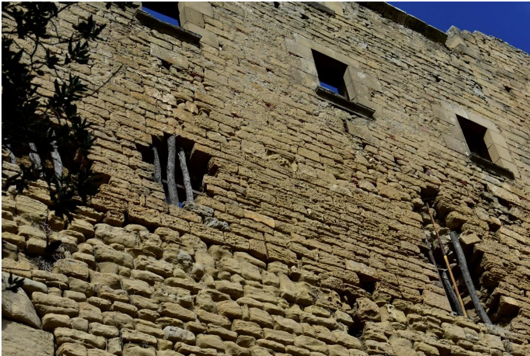
Figura 16. Pared suroeste del edificio erigido en la parte derecha de la torre del homenaje (11 de noviembre de 2023). Fuente: propia.
