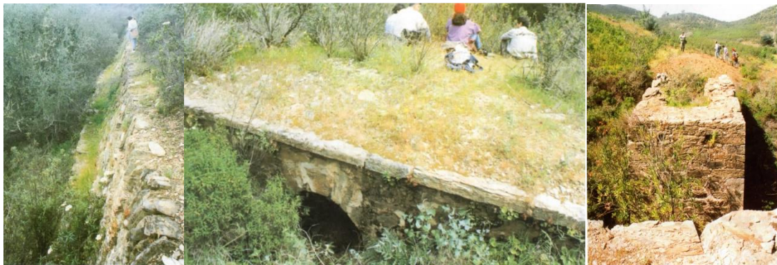
Fig. 5.2. Infraestructuras de la plataforma y obras de infraestructura del ferrocarril.
