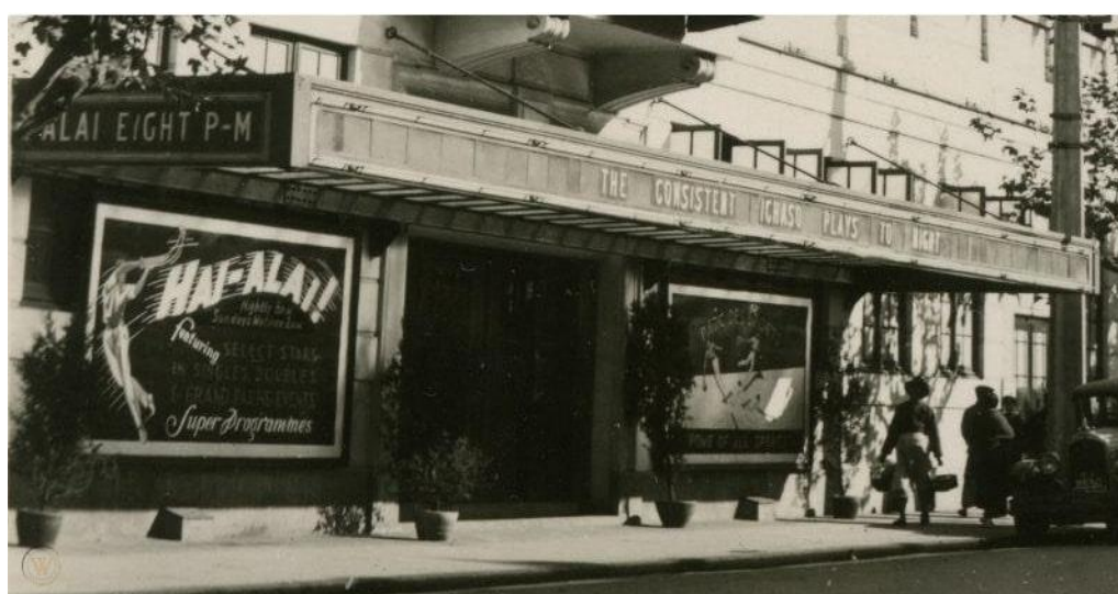
Figura 7: Entrada en la fachada principal del Auditorium
