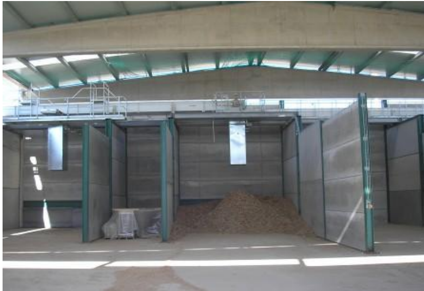
Foto 39 vista exterior del almacén de combustible tratado y su sistema de alimentación
