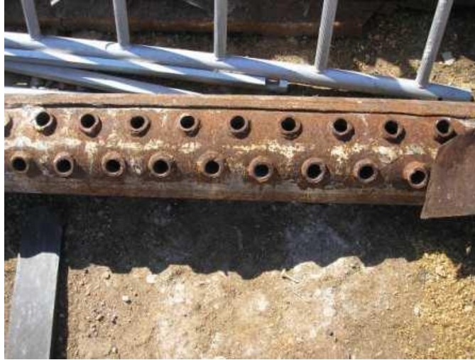
Foto 48 Detalle de uno de los colectores del sobrecalentador
