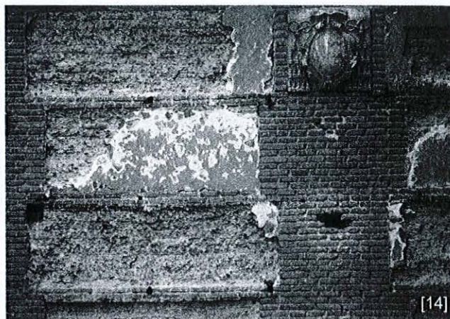
[14] Muralla de la fachada Norte antes de la restauración, con escudo de Sandoval y Rojas.
