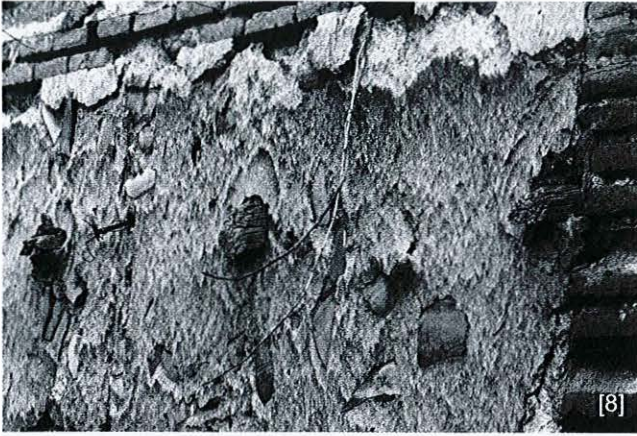
[8] Aspecto de un cajón con agujas de madera para sujetar el tapial o encofrado de tierra, enfoscado de yeso en una restauración moderna.
