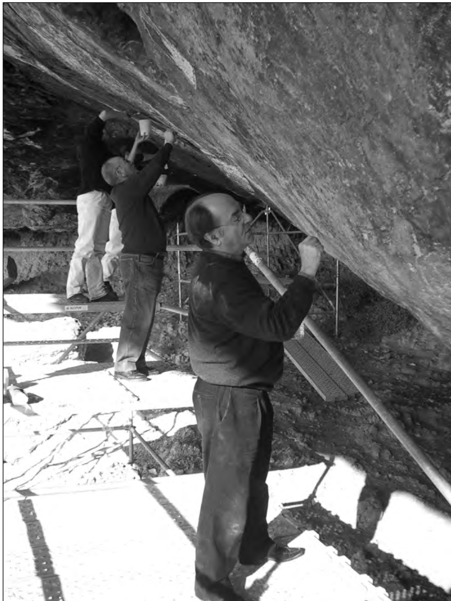
FIGURA 18. Detalle de las labores de restauración en la pared.
