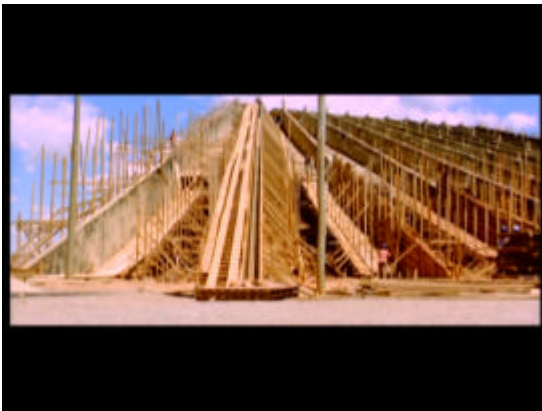
Foto 5. Pirámide en construcción: Secuencia 12
