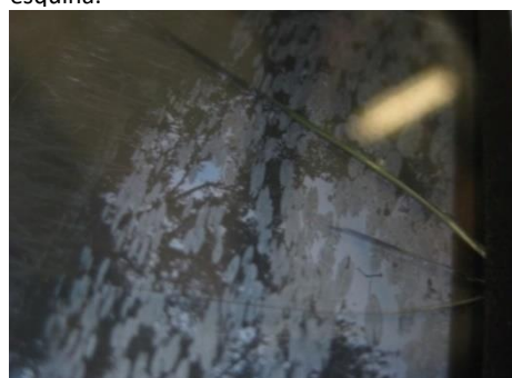
Fig. 26. Grietas y fragmentación en el vidrio.
