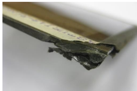
Fig. 25. Fragmentación y pérdida en una esquina.
