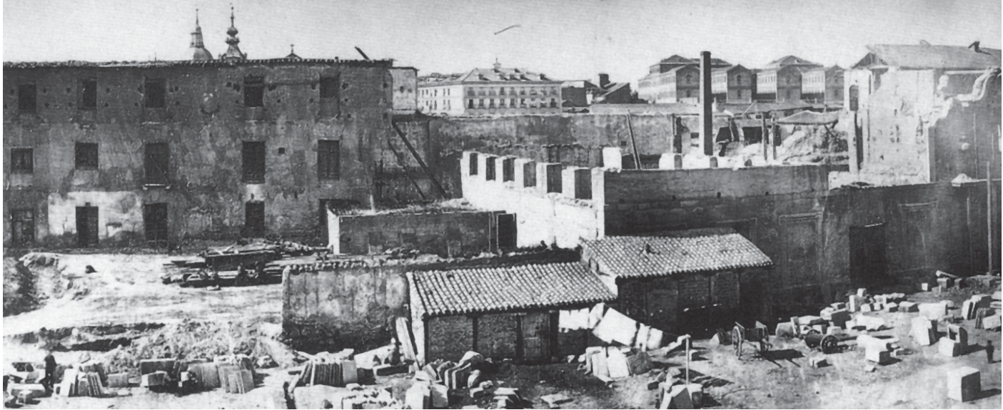
Fotografía del convento de las Salesas, desde la antigua posesión de Monte León, en 1869.
