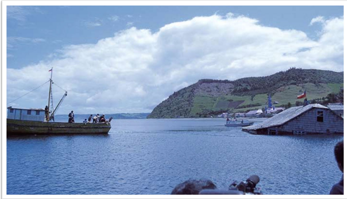
Fig.- 27 Casa con los flotadores puestos para el traslado por mar. 282
