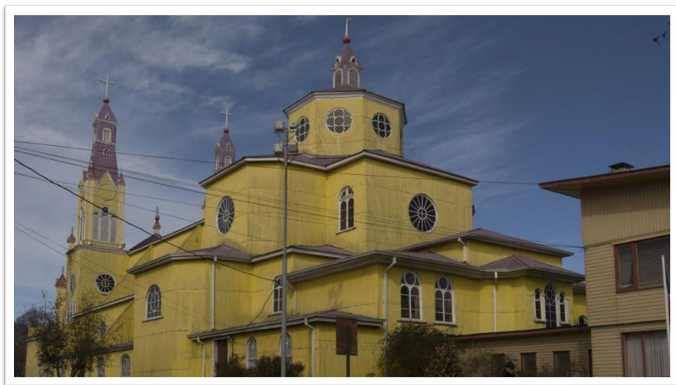
Fig.- 109 Vista desde el lateral derecho, calle: San Martín. 445
