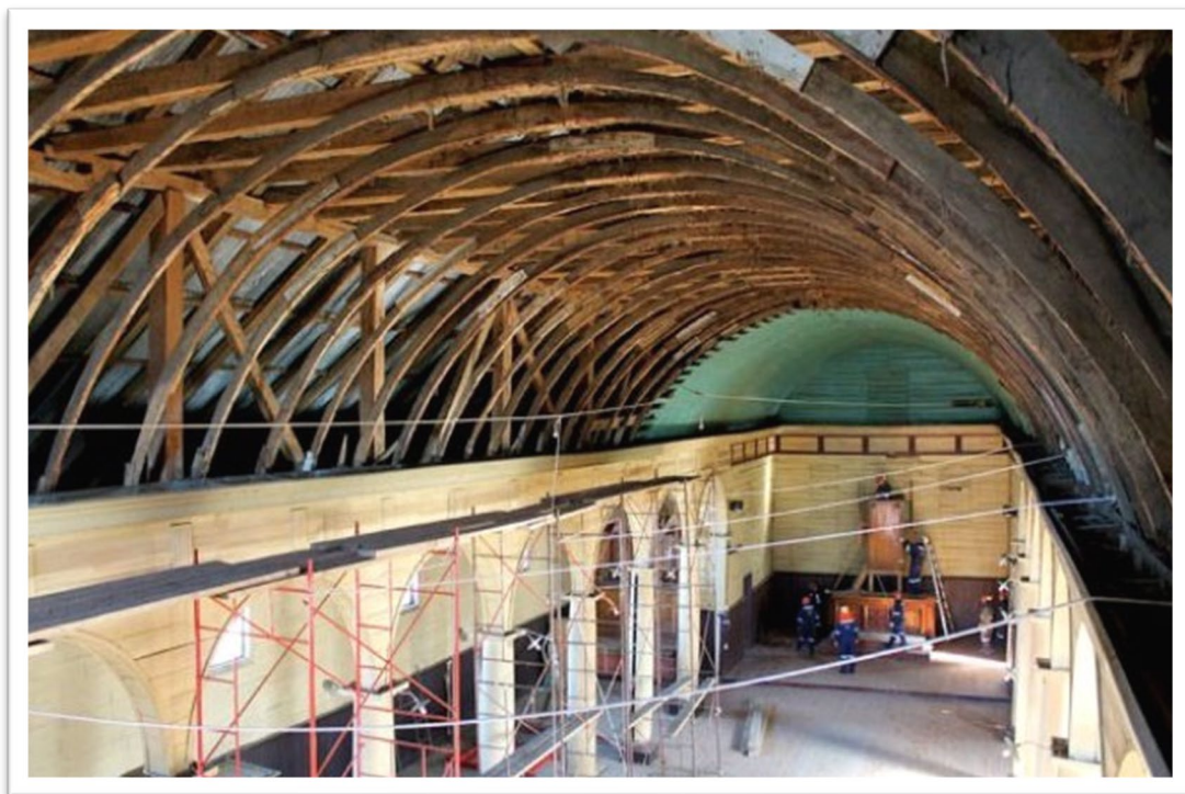
Fig.- 62 Proyecto de restauración, año 2012-2013. 393
