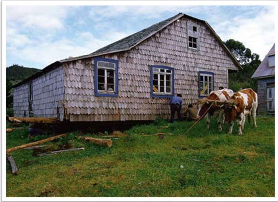
Fig.- 26 Amarre de la casa para el traslado. 281
