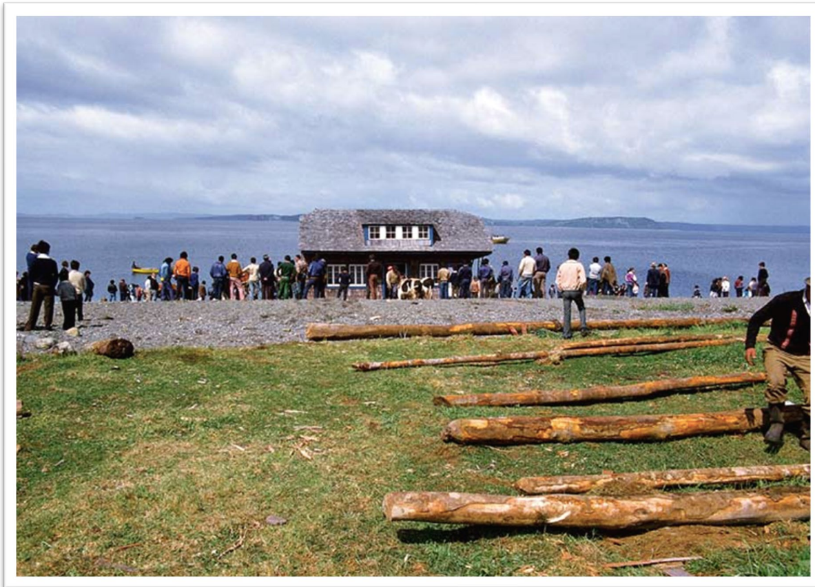
Fig.- 25 Preparación para la tiradura de la casa chilota. 280
