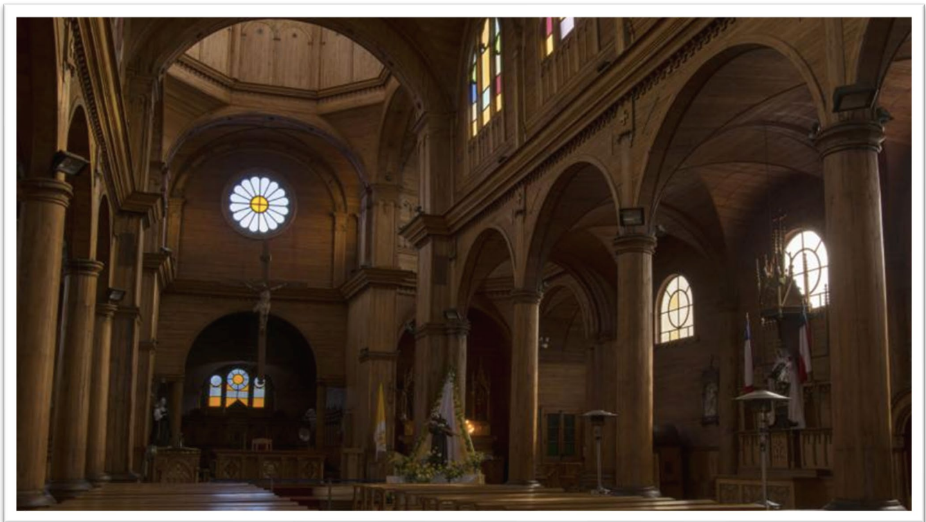
Fig.- 114 Columnas de madera de arco medio punto. 450
