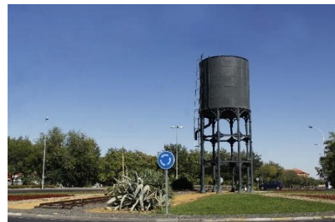
Fig.13: Depósito de agua en Ciudad Real, 2020.
