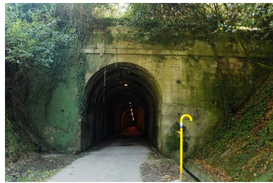
Fig. 41: Boca oeste del túnel, 2020.
