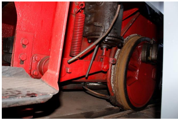
Fig. 121: Salida del agua condensada y vapor, 2020.
