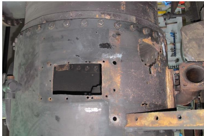
Fig. 61: Envolvente de la caldera, estado previo a la restauración, 2014, Museo del Ferrocarril de Asturias.
