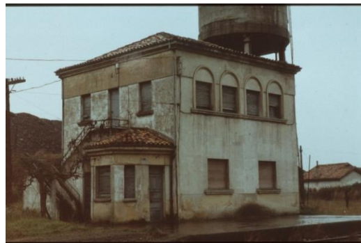
Fig. 39: Estación y depósito de agua, hemeroteca, 2008.
