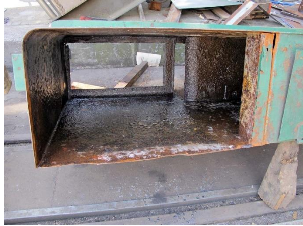
Fig. 98: Estado previo de los depósitos , 2014, Museo del Ferrocarril de Asturias.
