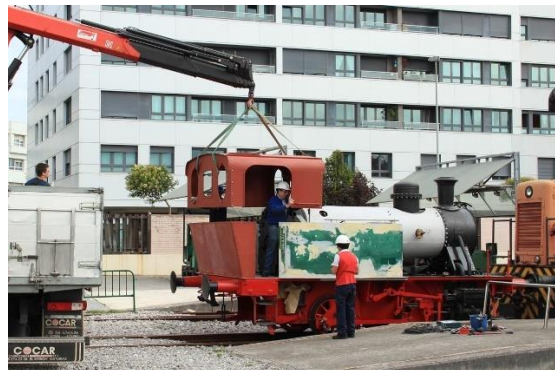
Fig. 103: Montaje de la cabina , 2014, Museo del Ferrocarril de Asturias.
