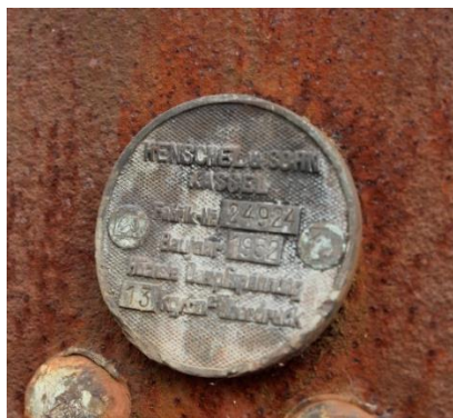
Fig. 30: Chapa de inspección de la caldera original, 2020.
