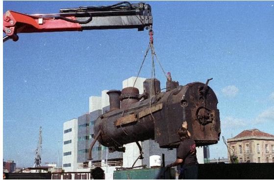
Fig. 92: Desmontaje caldera, 2013, Museo del Ferrocarril de Asturias.
