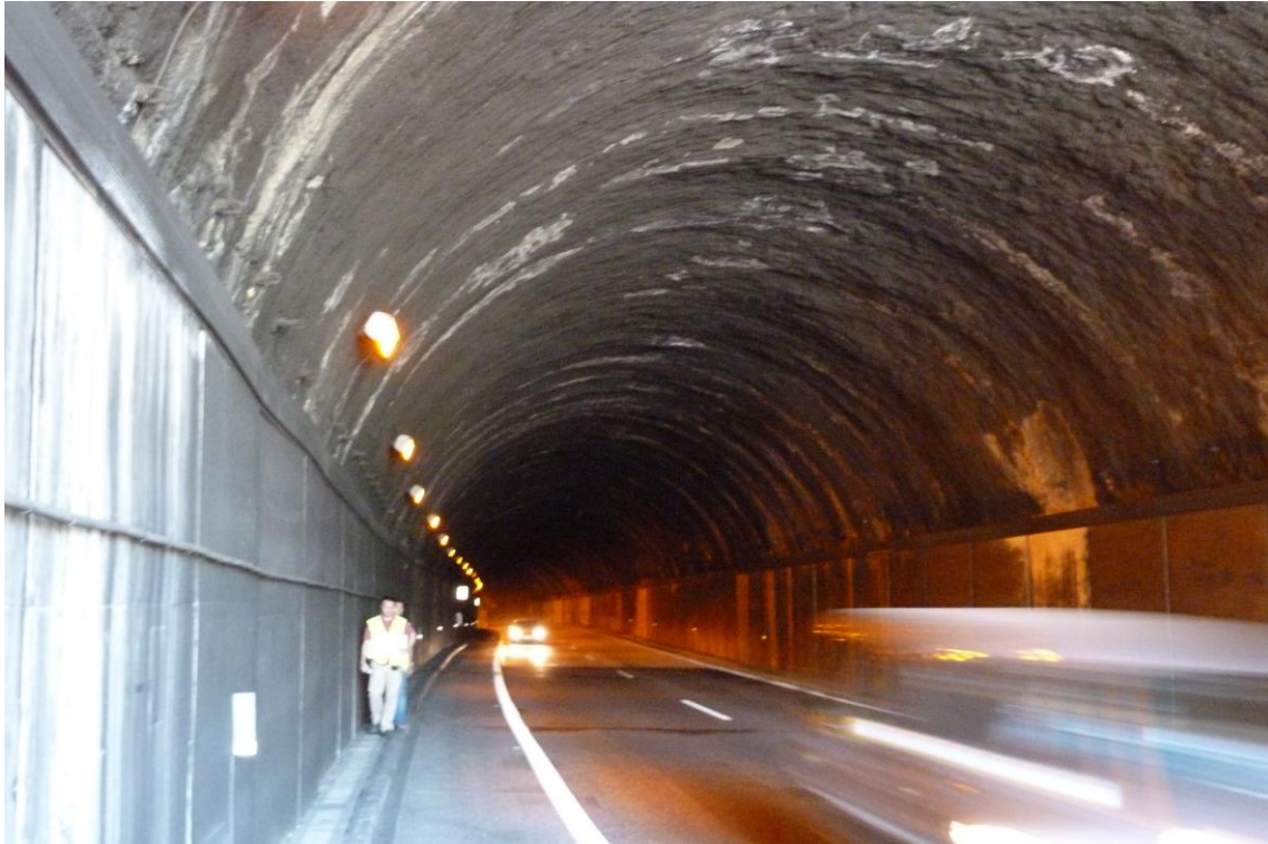
Foto 4.1 Soporte del túnel con bóveda de hormigón encofrado sobre muros (Castanedo, 2015)
