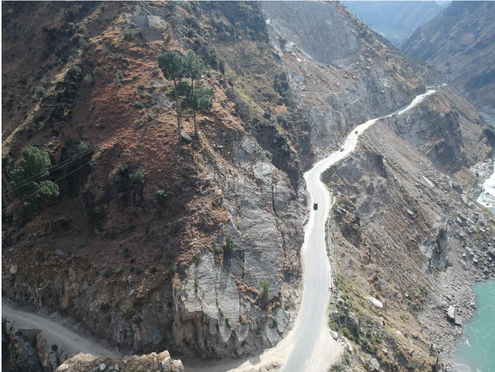
Foto 3.3 Vista acumulación derrubios invadiendo cauce (Space & EPSA, 2020)
