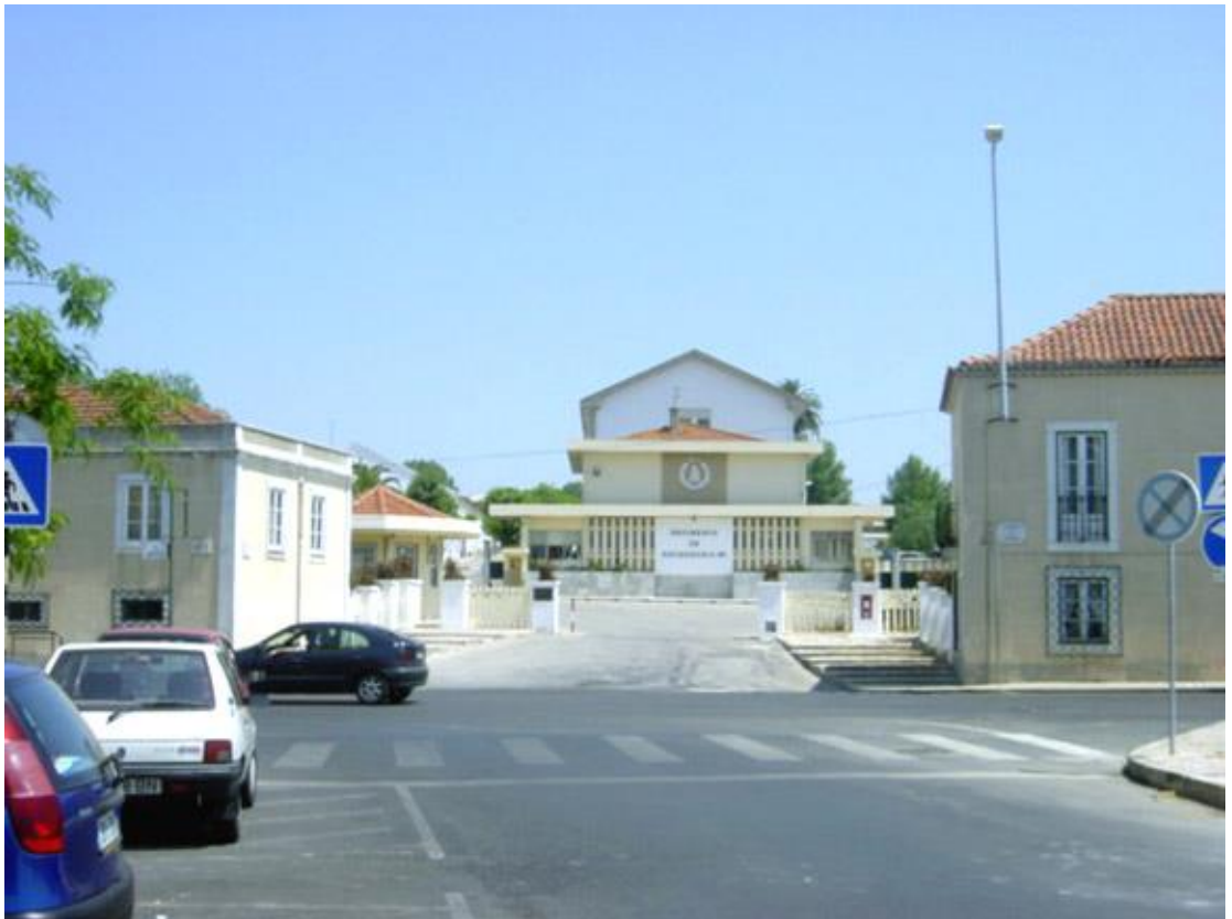
Fig. 10 .- Sé do Regimento de Engenharia nº 1
