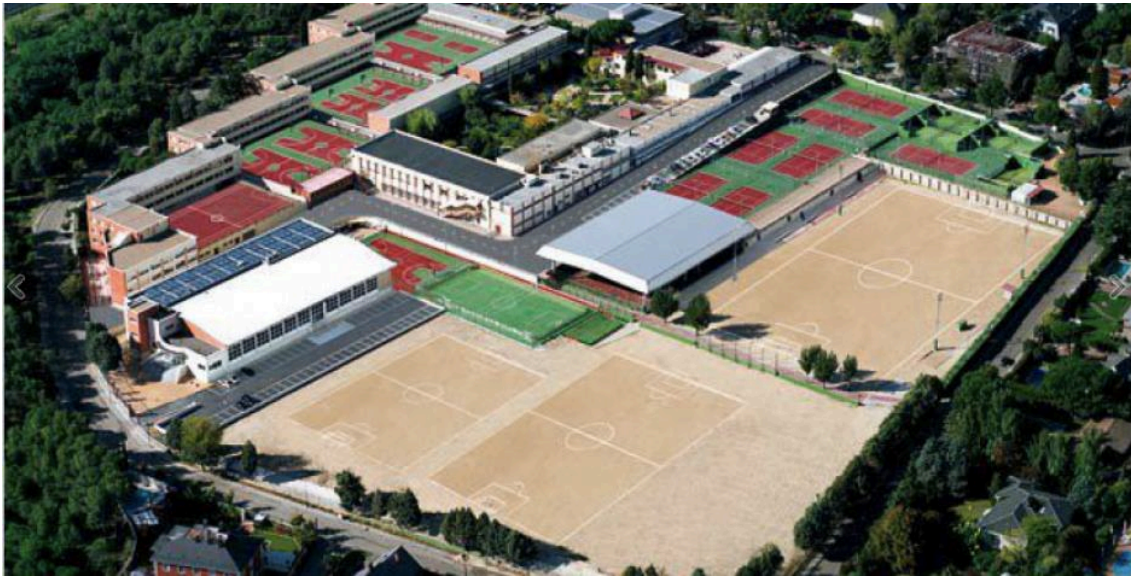
Figura 19. Foto aérea del colegio Maristas San José del Parque
