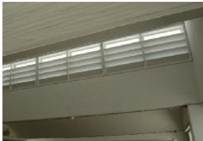
Vista interior de un lucernario de cubierta desde el que la entrada de luz es muy controlada.
