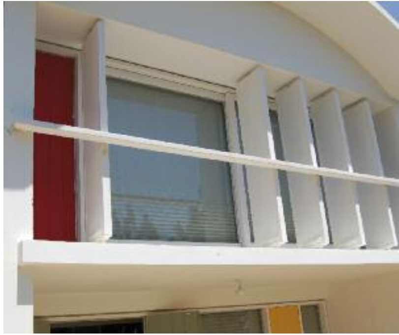
Ventanales de la fachada norte (izq.) y paneles verticales y alero de cubierta para la protección de la ventana de la fachada sur (dcha.). En el interior se le había añadido una persiana opaca.
