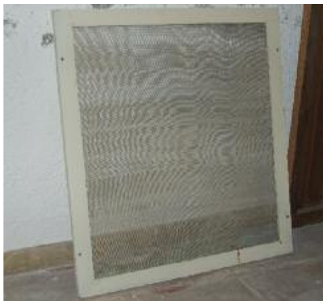
Detalle de la carpintería fija que en el momento de la visita cerraba los lucernarios de cubierta (sup.) y elemento de una antigua carpintería en su momento desechada en la que se utilizaba una malla que permitía la ventilación del taller.
