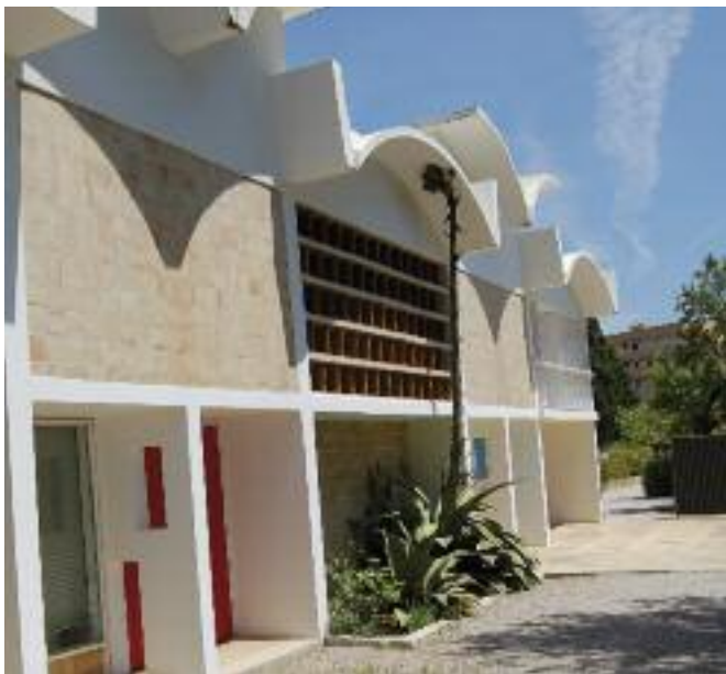
Fachada sur en la que se observan los diferentes elementos del diseño arquitectónico que permiten controlar el efecto de la insolación.
