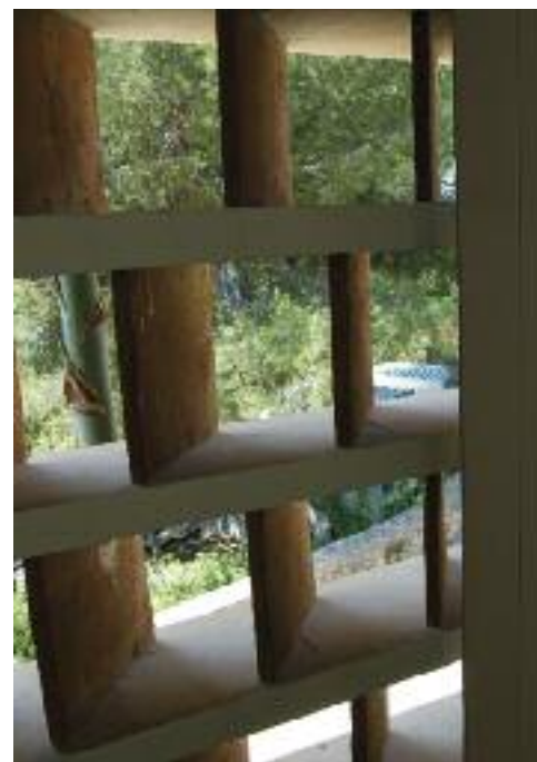
Elemento de lamas fijas en la fachada sur con la orientación estudiada para impedir el paso de radiación solar directa al espacio del taller.
