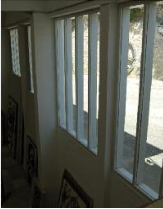
Ventanales de la fachada norte (izq.) y paneles verticales y alero de cubierta para la protección de la ventana de la fachada sur (dcha.). En el interior se le había añadido una persiana opaca.
