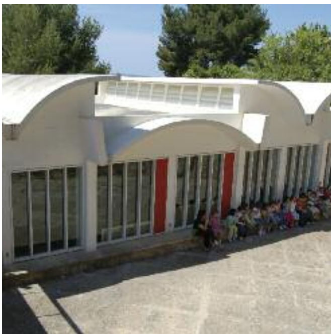
Vista general de la cubierta con los lucernarios de orientación este y oeste, y vista general del ámbito de la terraza norte.
