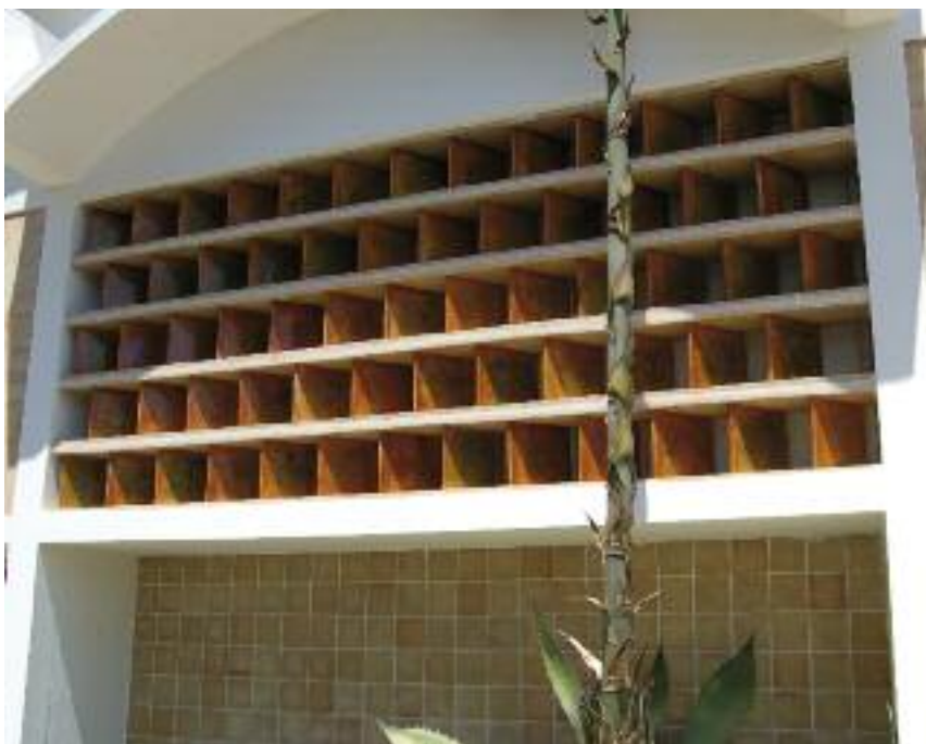
Elemento de lamas fijas en la fachada sur con la orientación estudiada para impedir el paso de radiación solar directa al espacio del taller.
