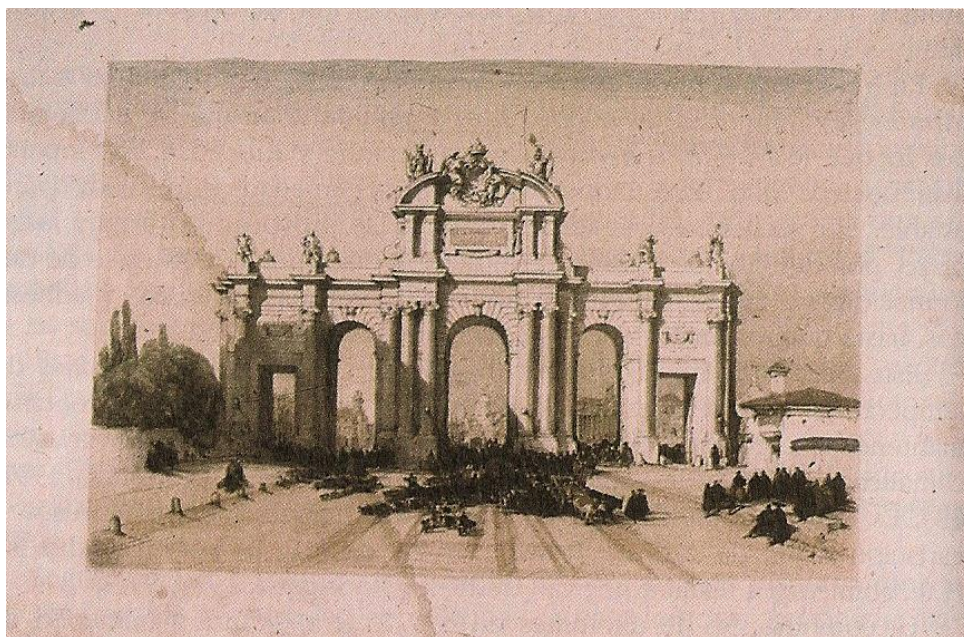
Imagen 14: Estampa afectada por humedad (Fototeca del Patrimonio Histórico, Archivo de Obras Restauradas, I.C.R.B.C. Ministerio de Cultura).
