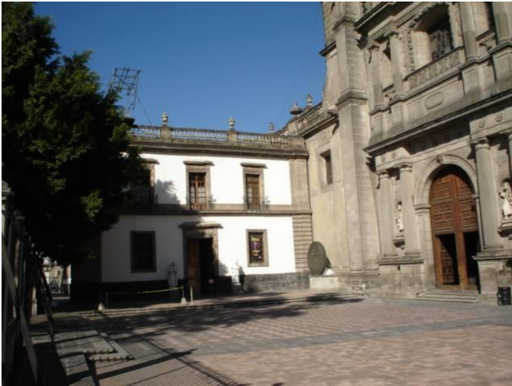
Imagen 21. Fachada Biblioteca Turriana, Ciudad de México.
