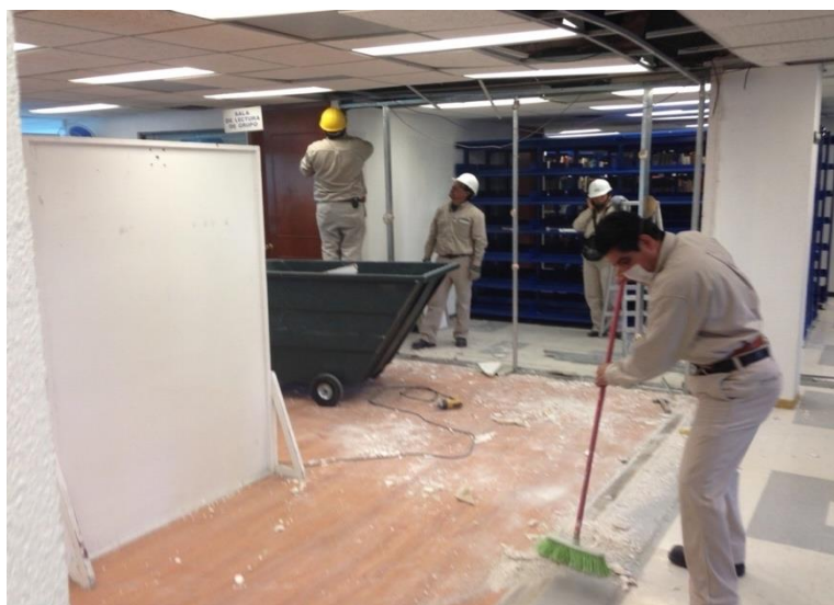
Imagen 125. Demolición de los muros de Tablaroca ( Drywall ), y limpieza.
