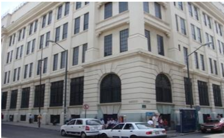
Imagen 79. Fachada del edificio “El Águila”, Tampico, Tamps. 2010.
