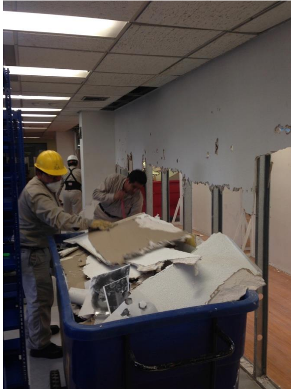
Imagen 124. Demolición de los muros de Tablaroca ( Drywall ).
