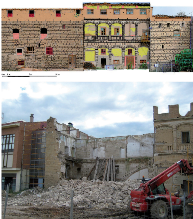
Figura 5. Plano de alzado del palacio de los Condestables en Casalarreina (La Rioja), realizado en 2006 (arriba). Estado del palacio tras su derrumbe en el año 2008.
