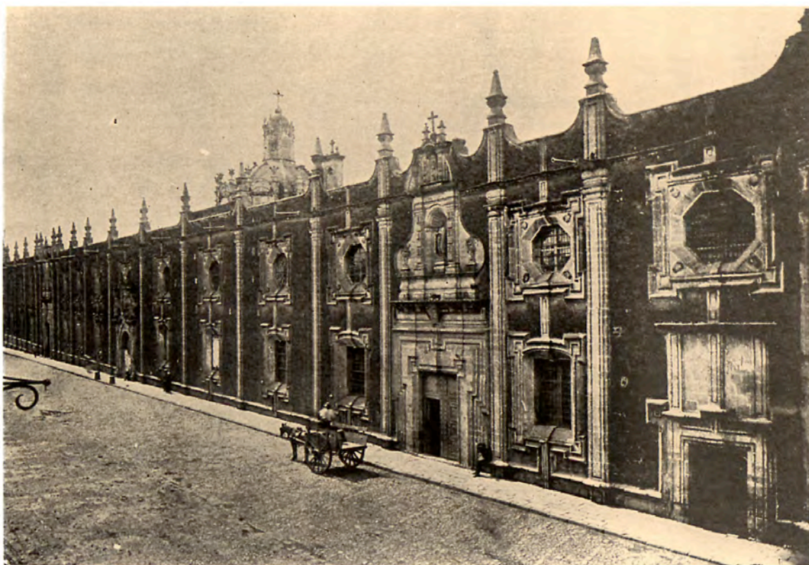
Fotografía antigua de la fachada principal; la portada visible es la de la casa del capellán; la de la esquina es la entrada norte de la accesoria 62, que tiene otra entrada por el poniente (tomada de Muriel, p. 146).
