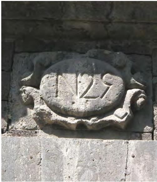
Los bellos numerales de las accesorias de Vizcaínas esculpidos en cantera de Chiluca aún se conservan hasta hoy.
