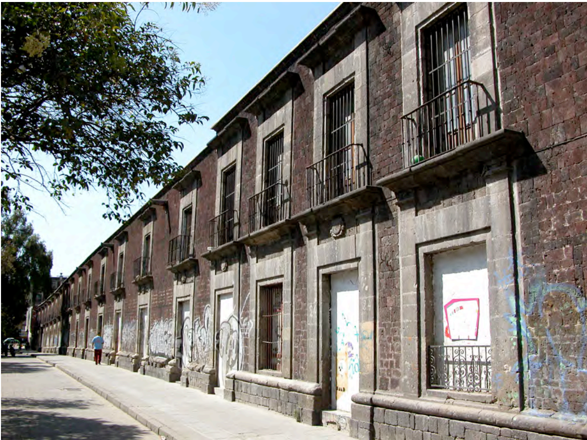
Aspecto actual de las accesorias del costado sur del Colegio de Vizcaínas
