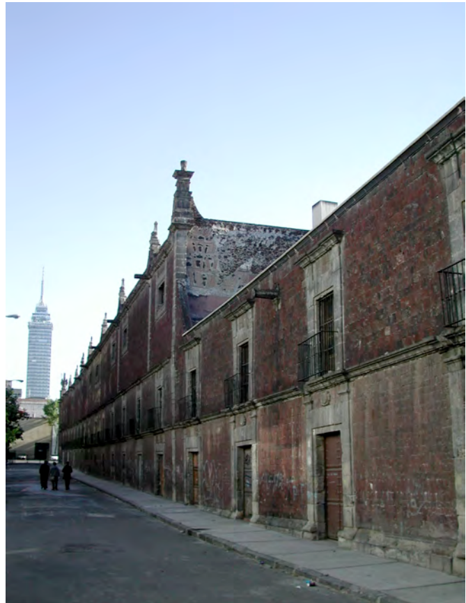
Vista de la fachada poniente del Colegio de las Vizcaínas. Todos los juegos de vanos de los bajos y el entresuelo corresponden a accesorias.
