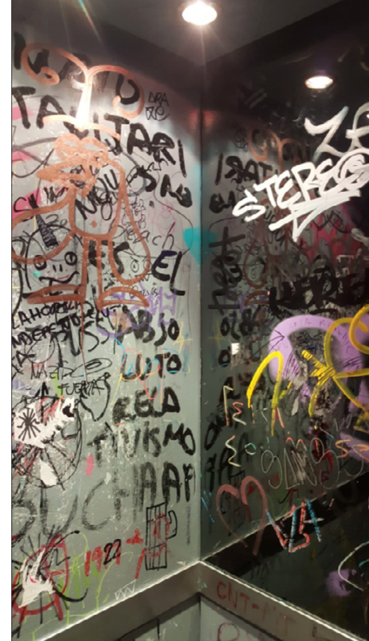
Fig. 25. Interior del ascensor de la Facultad de Bellas Artes UCM (Santamaría, 2020)
