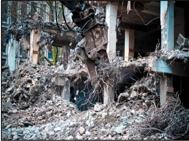
Residuos de construcción y demolición.
