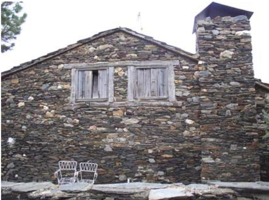
Fig. 14. Restauración empleando materiales locales y su colocación tradicional.
