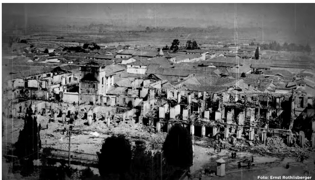
Figura 2. Incendio Galerías Arrubla
