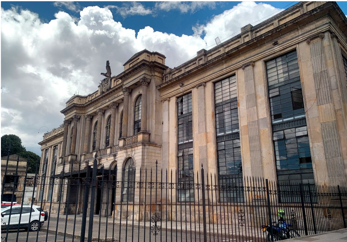
Figura 12. Estación ferrocarril de la Sabana (2021)
