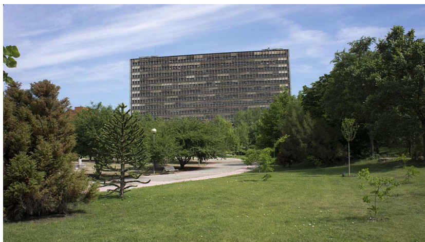
Figura 17. Edificio de la Facultad de Ciencias Biológicas. Fuente: UCM.
