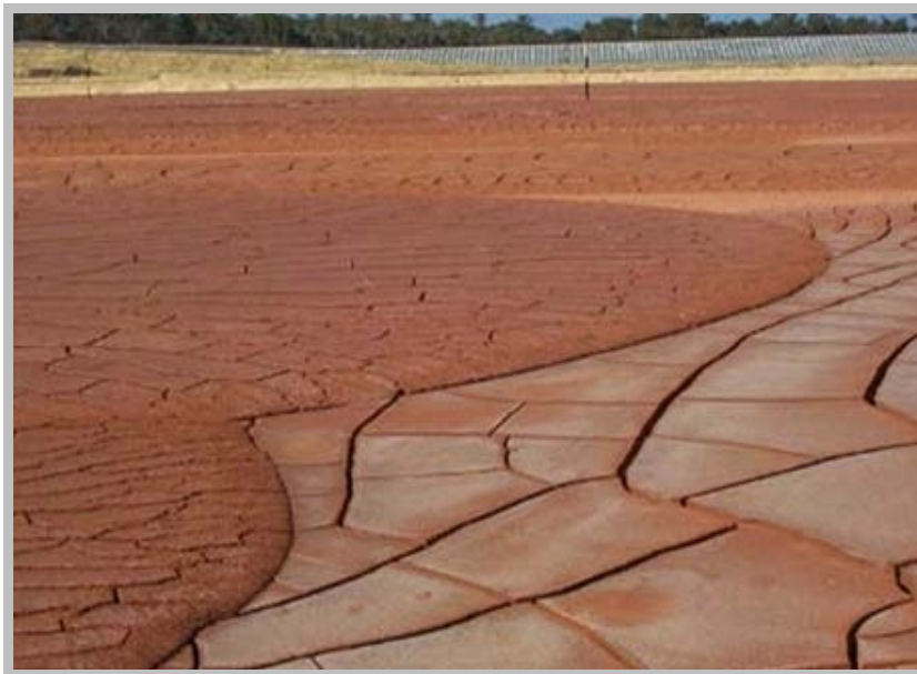
Figura I.1.1.- Balsa de “lodo rojo” del accidente de la fábrica de alúmina de Hungría [7]
