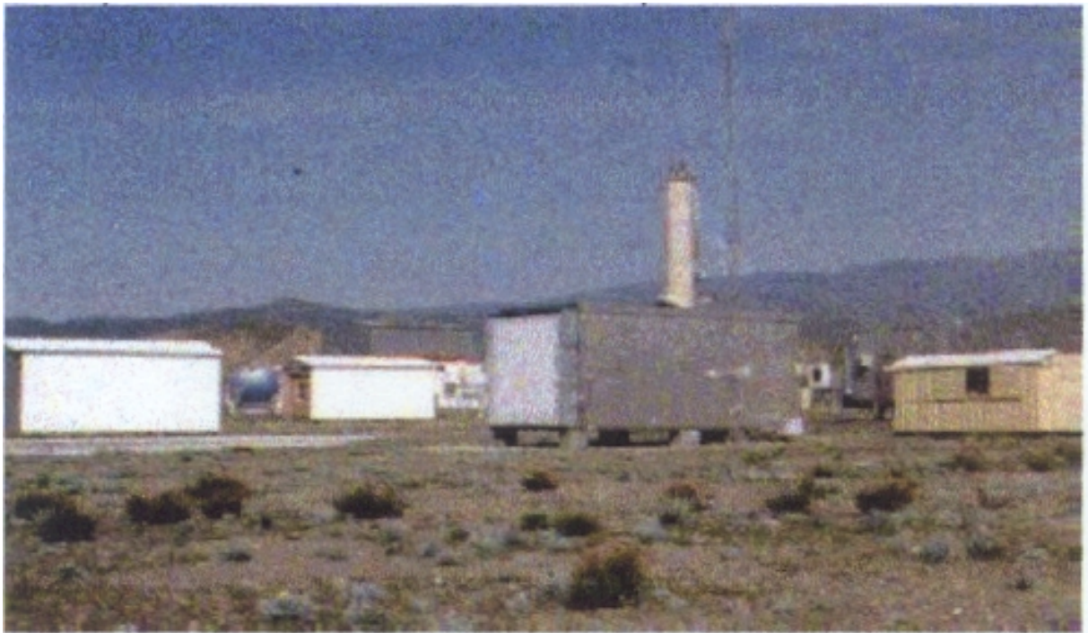
Panorámica General de las Instalaciones.
