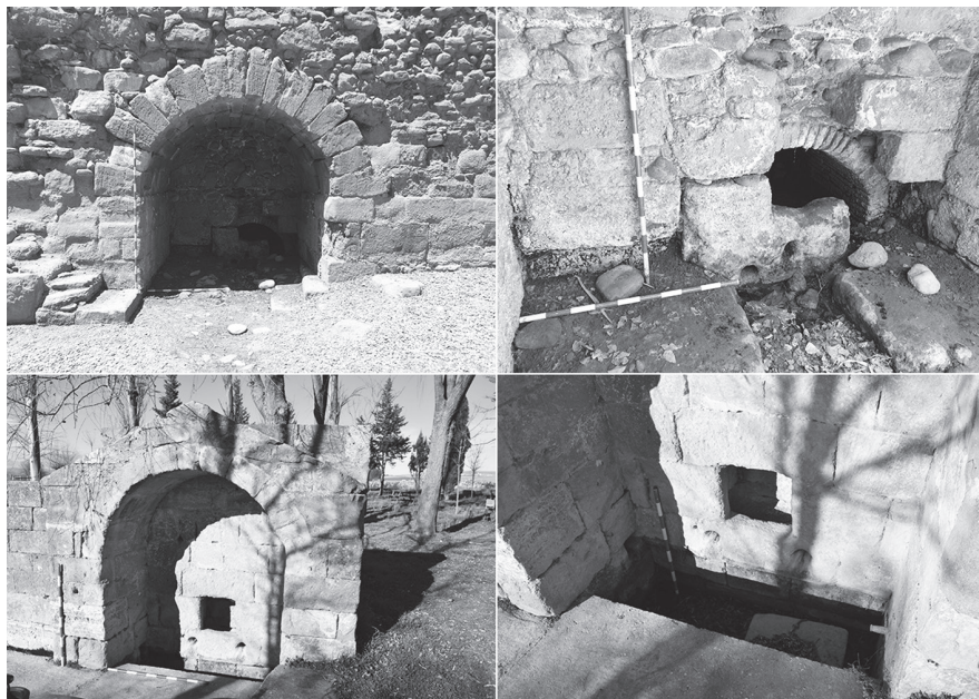
Figura 1. Las dos imágenes de la parte superior se corresponden con el ninfeo de Alfaro (La Rioja). En la esquina superior izquierda una vista general de la estructura. En la esquina superior derecha detalle de la entrada al depósito de captación. Las dos imágenes de la parte inferior corresponden a la fuente abovedada de Muro de Ágreda (Soria). En la esquina inferior izquierda una vista general de la estructura. En la esquina inferior derecha detalle del vano.
