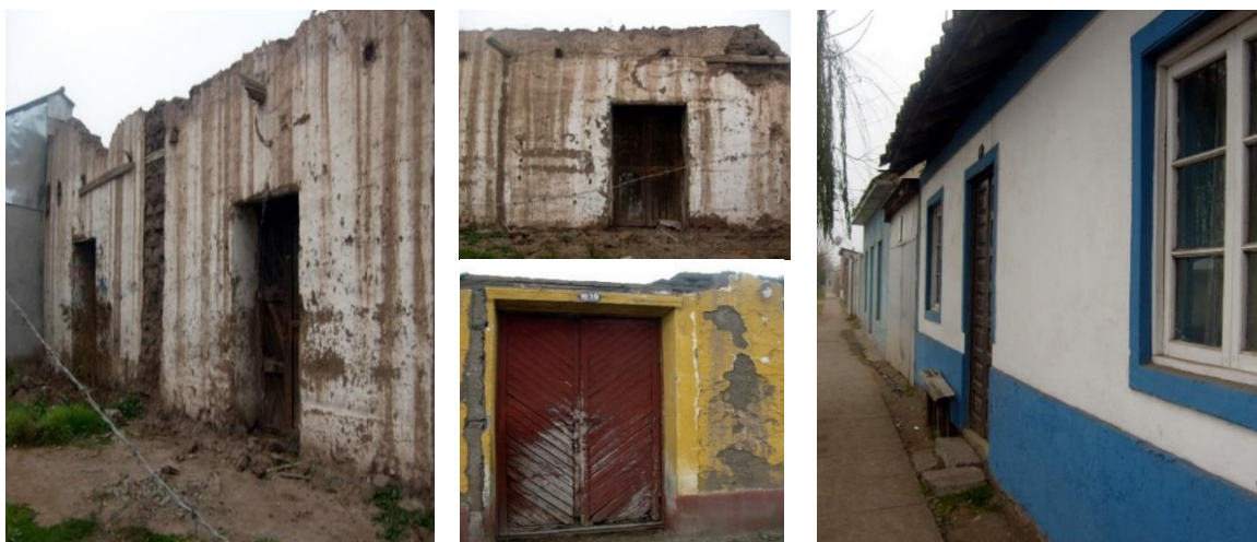
Imagen 3. Las casas en los valles centrales, cambio y permanencia
