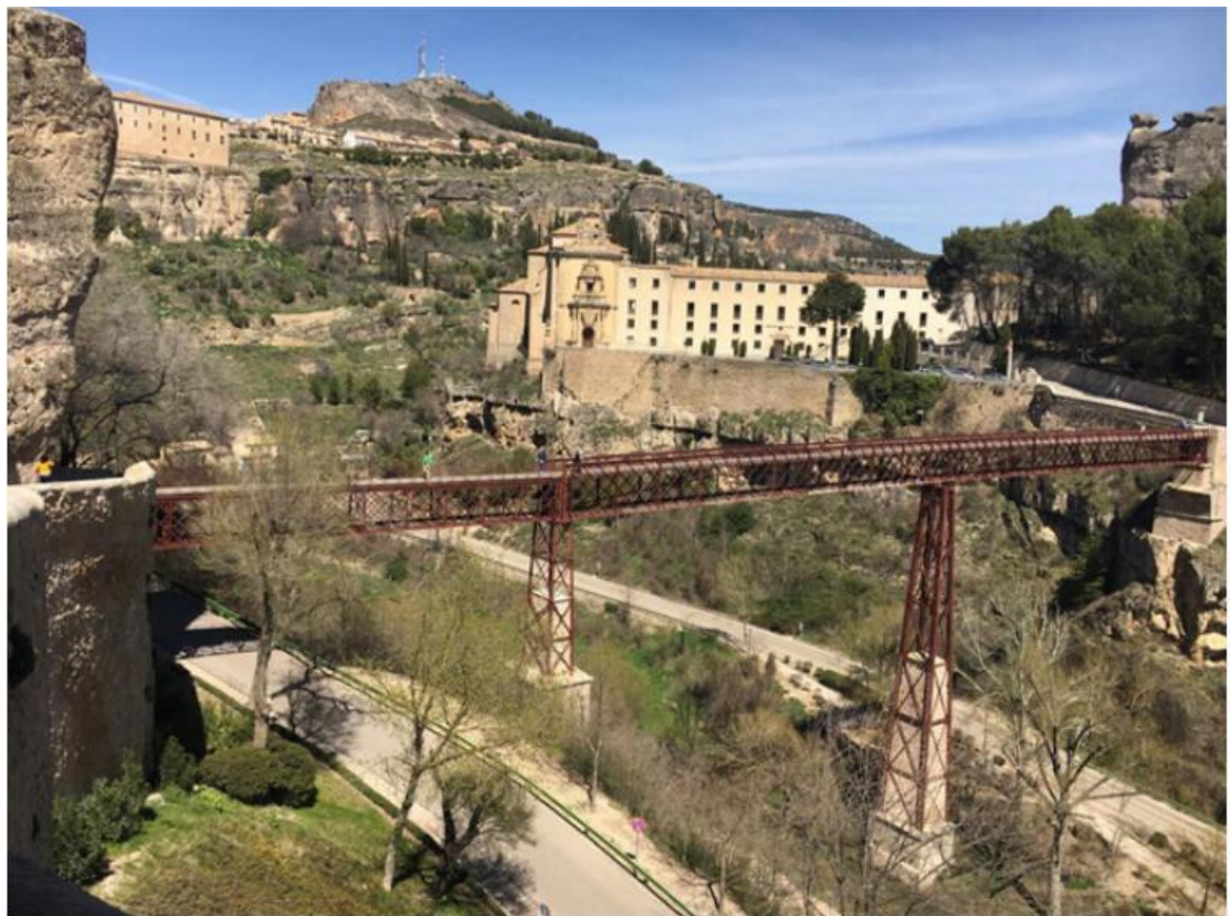
25. El puente de San Pablo en Cuenca (fotografía de la investigadora)
