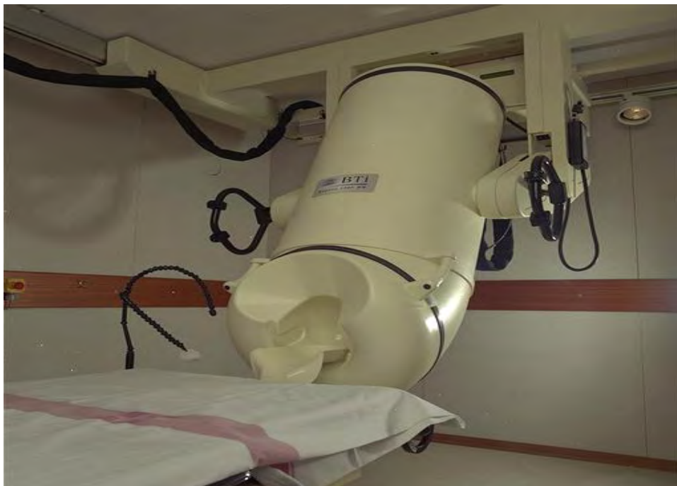
FIGURA 13: CÁMARA AISLADA EN LA QUE SE ENCUENTRA EL EQUIPO MEG.
