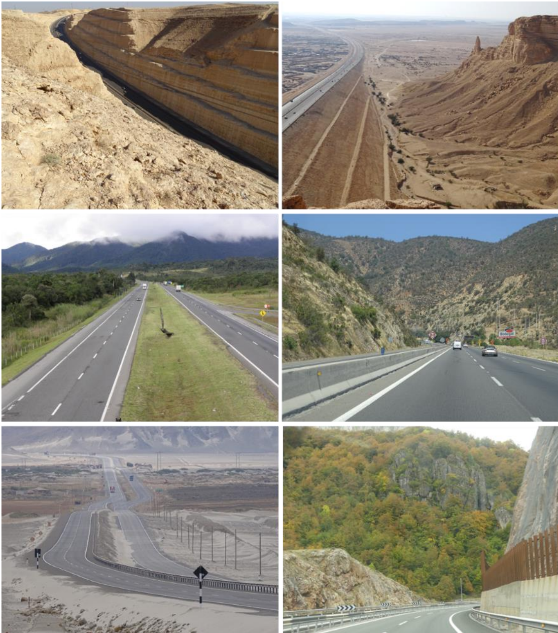
Figura 1.2. Autopistas en el mundo. Las dos imágenes de la parte superior corresponden al mismo tramo de carretera, y constituyen una enorme trinchera, a la izquierda, y una gigantesca rampa, a la derecha, para salvar un escarpe rocoso en el desierto de forma prácticamente recta y perpendicular a la pendiente, imponiendo la infraestructura al terreno de forma efectista y simbólica, como una alegoría a la mano del rey hundiendo su espada en el terreno. Autopista entre Riad y La Meca (Arabia Saudí). En medio a la izquierda, la autopista Régis Bittencourt que une Sao Paulo y Curitiba a su paso por el Parque Estadual de mata atlántica Jacupiranga (Brasil). En medio a la derecha, la autopista de Santiago a Valparaíso (Chile), cuando cruza la sierra costera, cubierta de vegetación mediterránea. Abajo a la izquierda, la autopista panamericana al norte de Lima (Perú), atravesando el desierto costero. Abajo a la derecha la autopista del Huerna (España) en el entorno de un hayedo en la Cordillera Cantábrica (Fotografías de Ignacio Mola)
