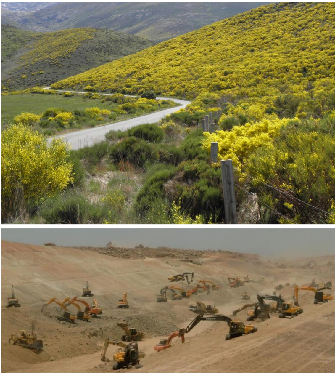
Figura 1.3. En la parte superior, carretera de Hoyos del Espino a la Plataforma de Gredos, en la provincia de Ávila (AV-931), construida en 1945 para favorecer actividades cinegéticas. Se puede apreciar cómo a pesar de encontrarse en una zona montañosa, se adapta perfectamente al terreno, minimizando los movimientos de tierra a costa de un trazado sinuoso. Abajo, obras del tren de alta velocidad entre Medina y la Meca (Arabia Saudí), donde la concentración de maquinaria pesada moviendo tierra resultó sobresaliente (Fotografías: superior de Ignacio Mola e inferior cortesía de Vicente Mayordomo. INECO)
