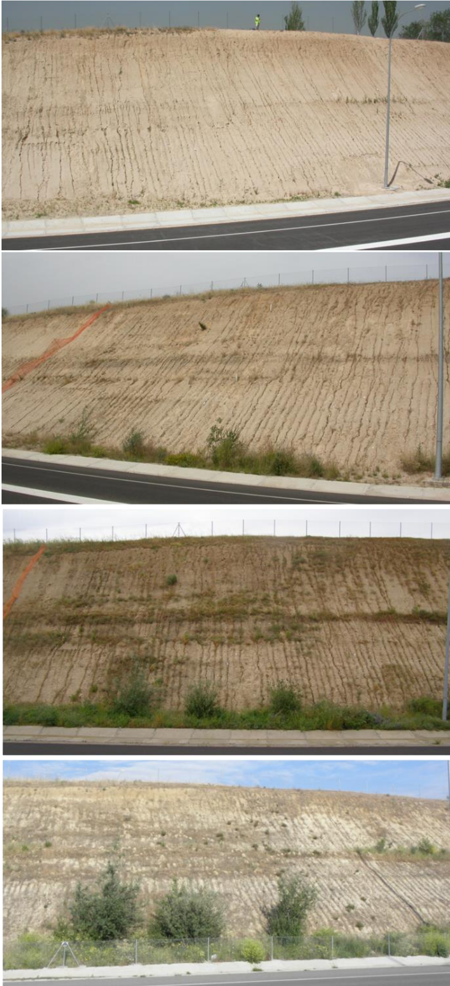
Figura 5.7a. Evolución del desmonte D-9 desde 2004, antes de la hidrosiembra, hasta 2008 (falta la foto de 2007)
