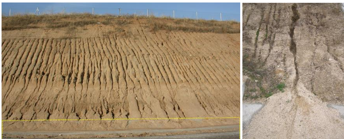
Figura 6.2. Red de drenaje superficial establecida sobre un desmonte de carretera construido sobre arcosas (autopistas M-12 y M-13, Madrid). A la izquierda se ha destacado con una línea discontinua amarilla la cuneta de hormigón, prácticamente soterrada por el aporte de sedimentos. El centro de la cuneta está sin sedimentos, porque se concentra la escorrentía y produce un arrastre del sedimento o bien hacia el entorno, fuera de la plataforma de la vía o bien con el riesgo de colapsar los colectores transversales (Fig. 1.6). A la derecha un detalle de la llegada de un
