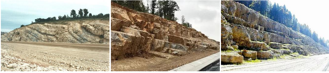
Figura 6.2. Tres ejemplos de aplicación del método Talus Royal© para la restauración de sendos desmontes sobre materiales consolidados (tomado de https://www.2g.fr/talus-royal ).
