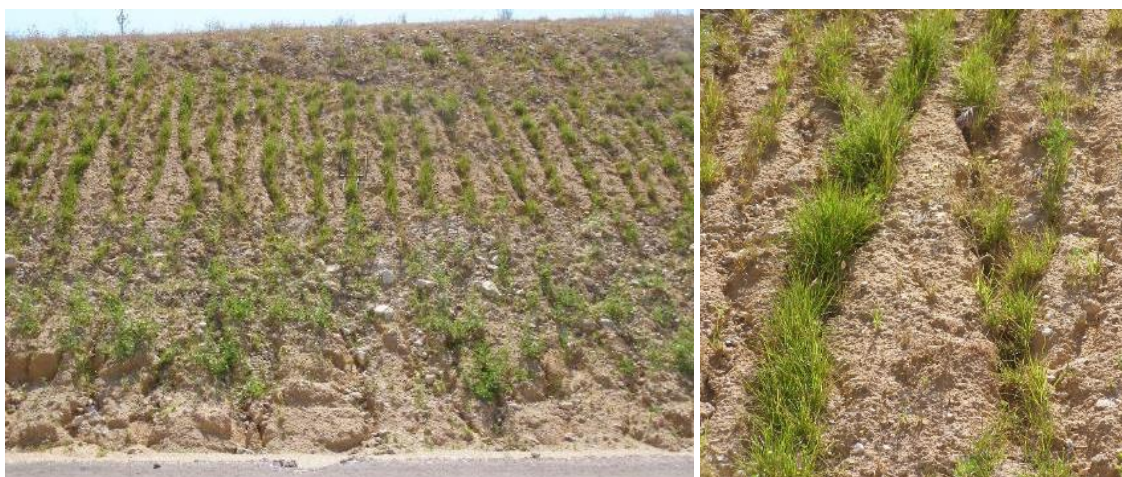
Figura 6.3. Desmonte sobre conglomerados y arcosas en la A-1 (circunvalación de El Molar, Madrid). A la izquierda una vista general al final del periodo constructivo. Se aprecia cómo está establecida la red de drenaje superficial en pequeños canales longitudinales. Sobre estos canales se concentra la vegetación. A la derecha un detalle del mismo talud.
