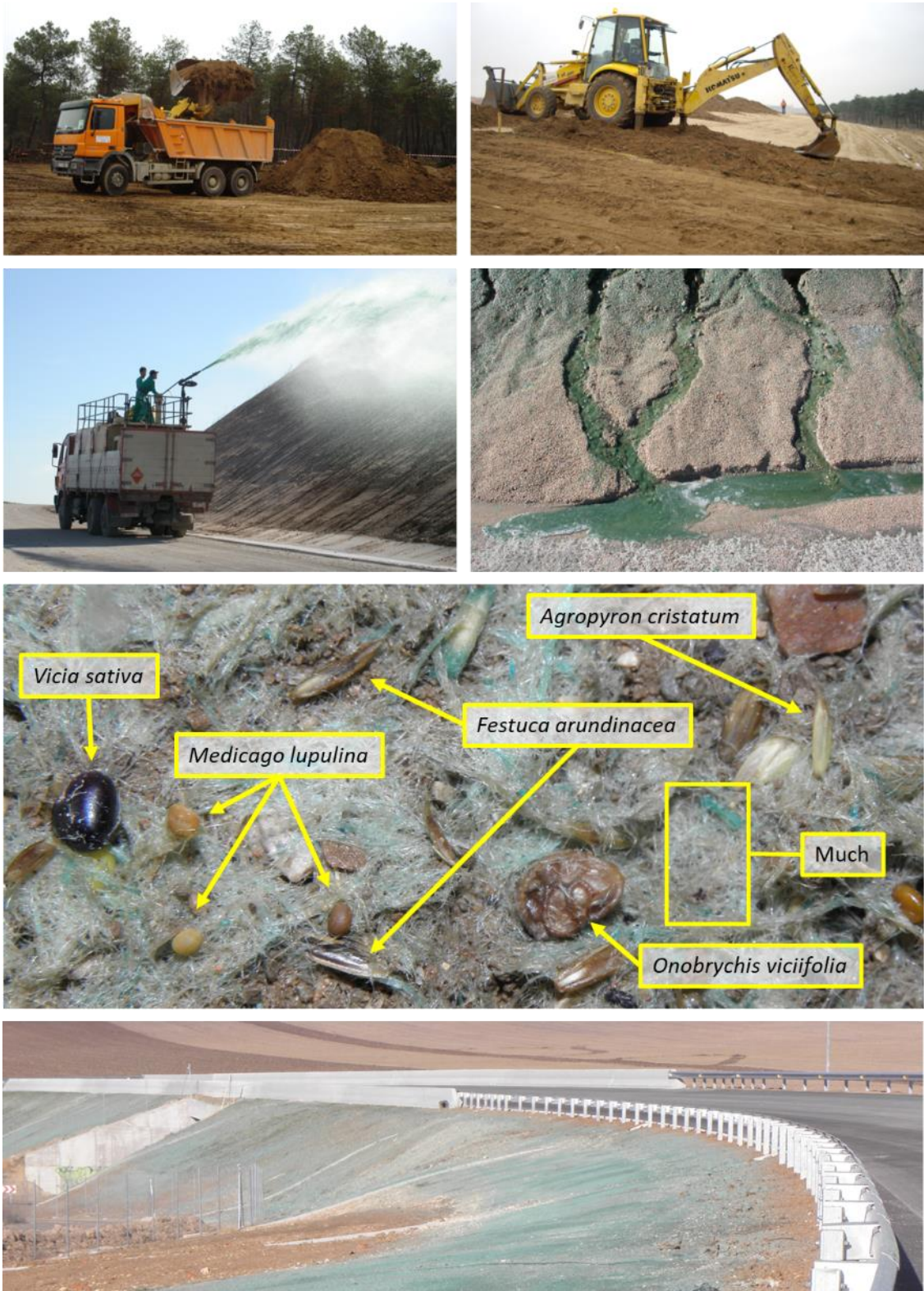
Figura 1.6. De arriba abajo y de izquierda a derecha: excavadora cargando tierra vegetal de un acopio en un camión. Retroexcavadora extendiendo tierra vegetal en un terraplén. Hidrosebradora trabajando sobre un desmorte. Mezcla de hidrosiembra escurriendo por el plano de un desmorte. Detalle del suelo en una zona recién hidrosembrada en la que se indican los elementos más aparentes. Terraplén recién hidrosembrado (diversas obras en la Comunidad de Madrid. Autores de las fotografías: las dos superiores, Berta Martínez, las dos del medio María Altamirano, las dos inferiores Ignacio Mola).
