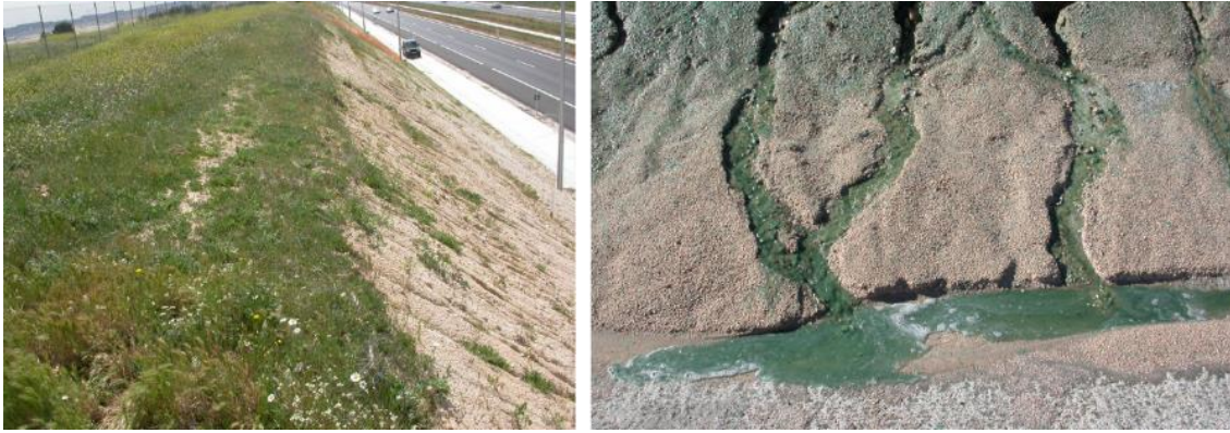
Figura 4.5. A la izquierda, cabecera de un desmonte (D-4), donde se aprecia la posición de la matriz o remanente de vegetación natural más próximo, justo en el borde de contacto con el plano del propio talud. A la derecha, la mezcla de hidrosiembra escurre por el talud, generando una red de escorrentía superficial, en este caso un desmonte, acumulando en la cuneta tanto la propia mezcla como sedimentos que arrastra a su paso (diciembre 2004).
