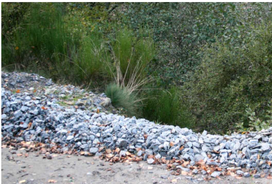
Figura 4.8. Situación de la entrada de agua, en contacto con mármoles grises, al punto B7.
