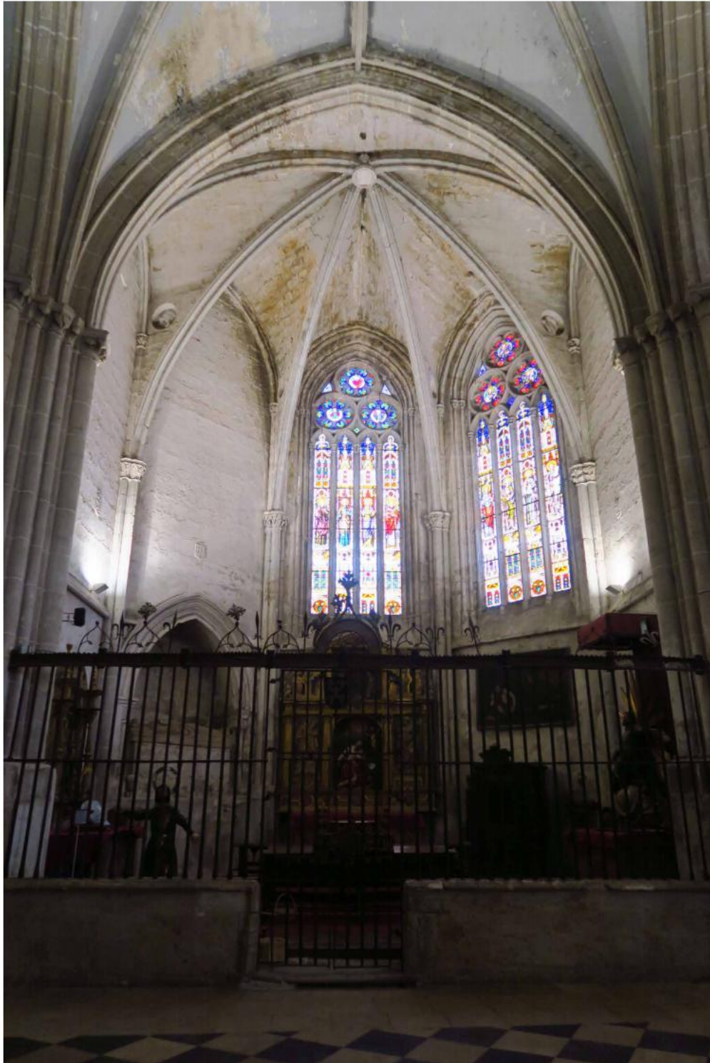
Fig. 1 Capilla de San Isidro, vista interior (fuente: Florentino Díez Sacristán, arquitecto).
