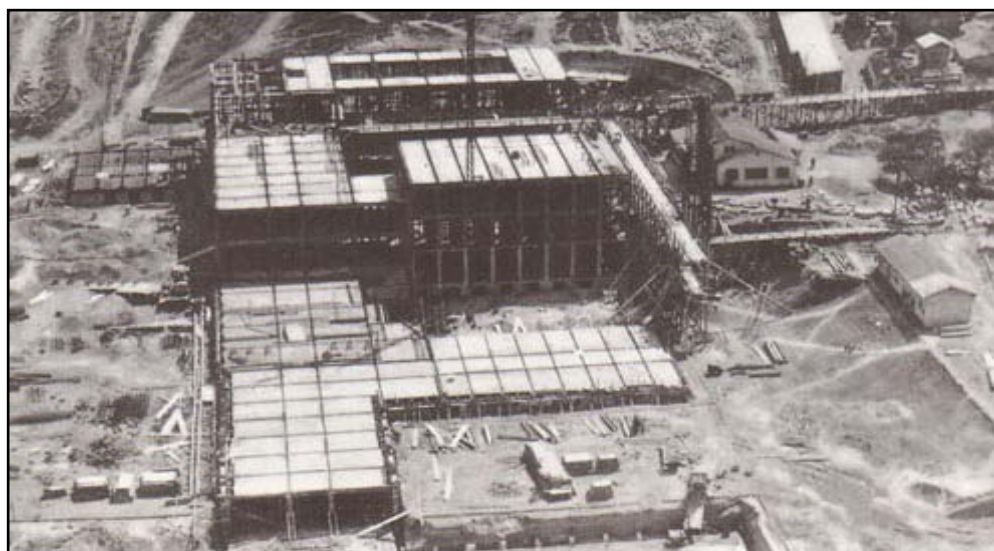
Edificio de la Escuela de Odontología en construcción. Empresa Agroman.
