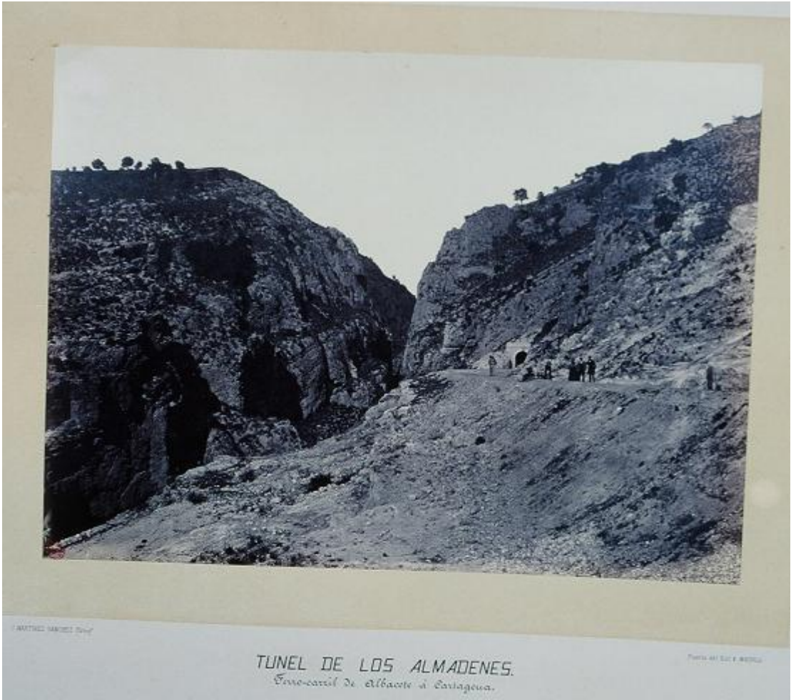
Túnel de Los Almadenes, José Martínez Sánchez, 1867
