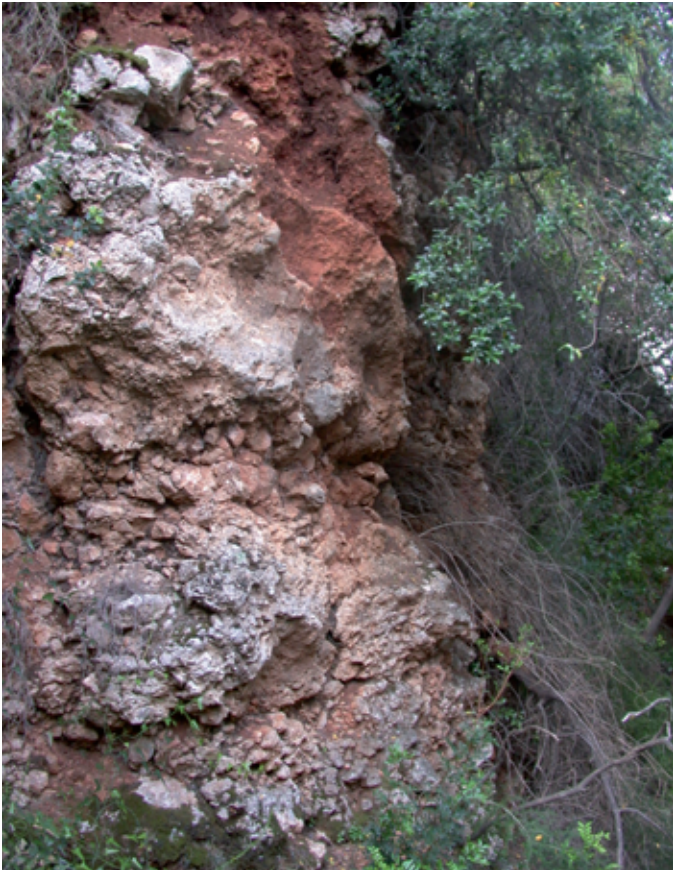
Figura 6. Escarpe de una de las grietas que afectan a las brechas cementadas del Pleistoceno superior, situadas ligeramente al sur de la coronación de la ladera inestable, y que constituyen una zona preferencial de infiltración.
