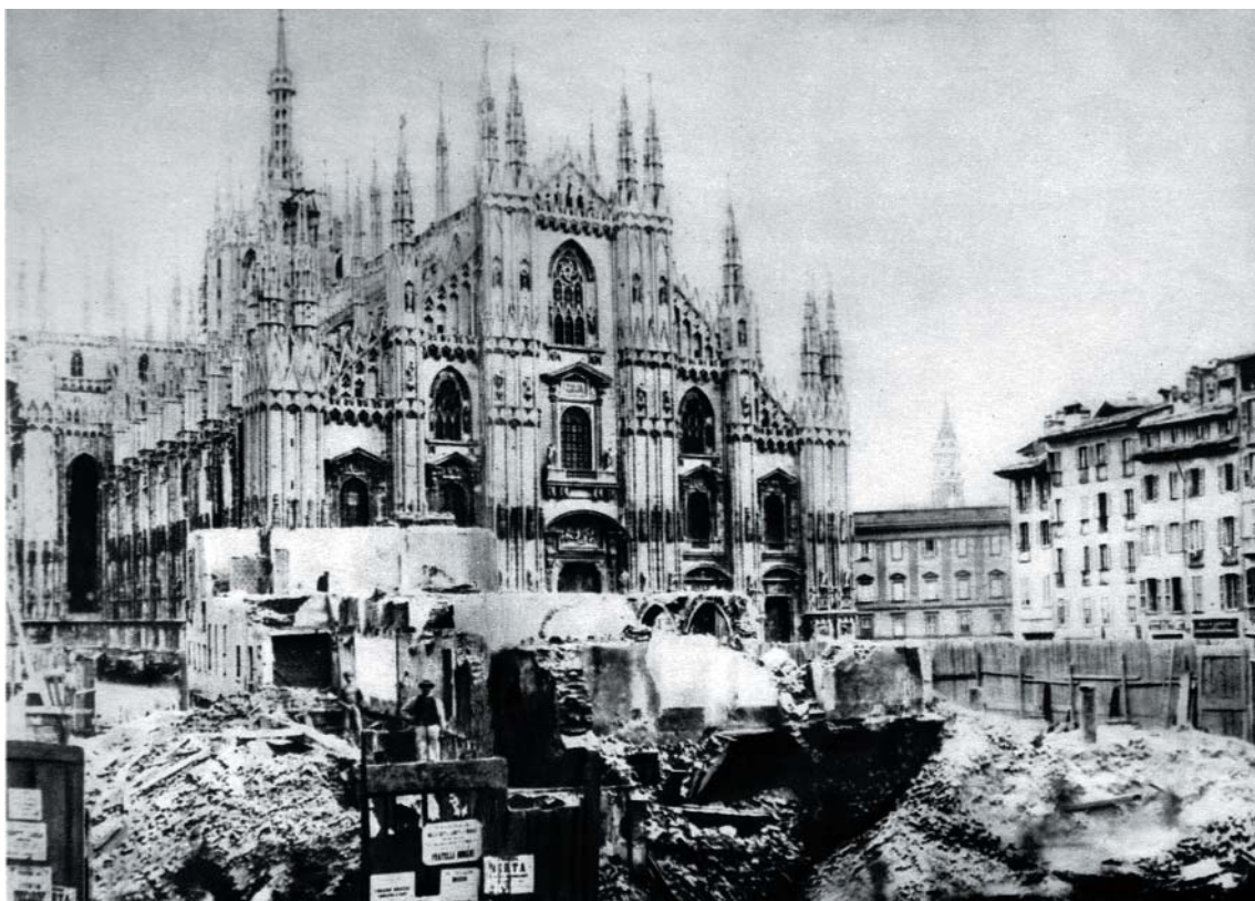
Remodelación de la plaza del Duomo. Se demolieron los antiguos pórticos para construir la Galleria Vittorio Emanuele .
