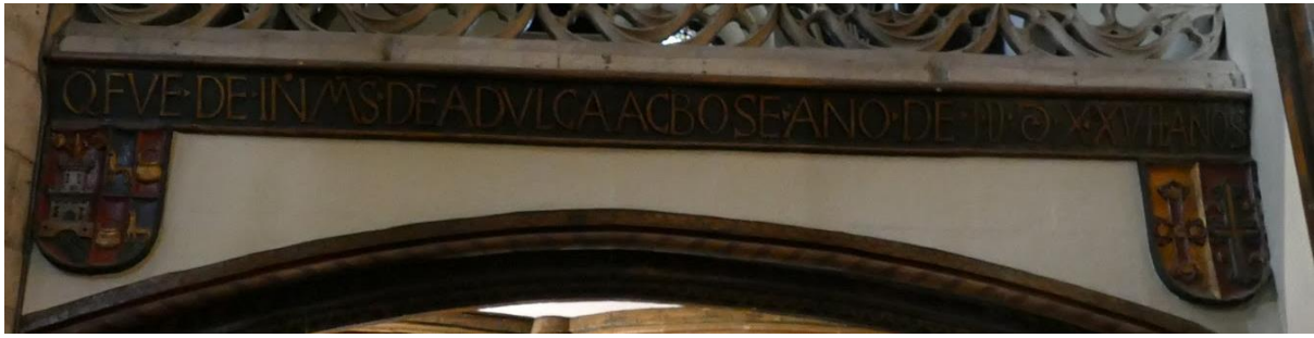
Lám. V, nº8: Roboratio del coro de la parroquia de San Miguel Arcángel.
