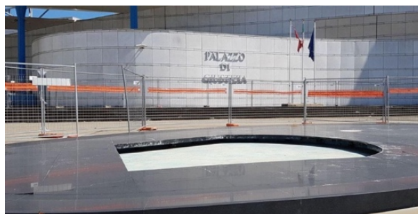
Figura 36.- La obra abandonada, a la espera de ser restaurada. [en línea], [consultado el 22/05/2018]. Disponible en: http://www.ilcentro.it/pescara/fontana-d-arte-nel-degrado-uno-sponsor-per-i-lavori-1.1693777
