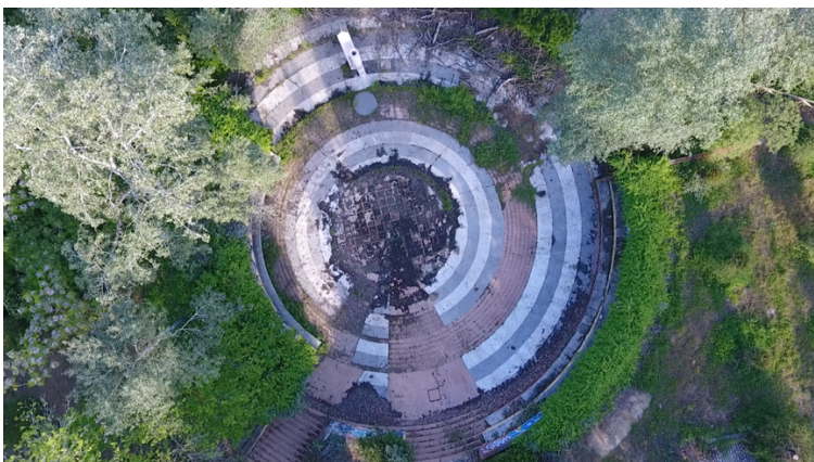
Figura 34.- Vista aérea del estado de conservación actual de la plaza de los músicos y la obra. Foto: Lara Rodríguez-Seara
