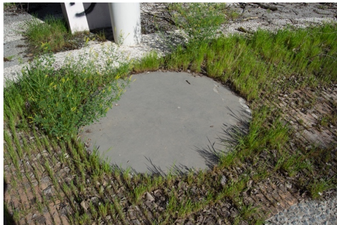
Figura 33.- Estado de la losa de mármol negro incrustada en el suelo: pérdidas, roturas, suciedad superficial y malas hierbas tapándola. Foto: Lara Rodríguez-Seara
