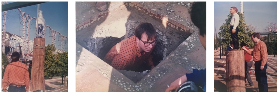
Figura 91.- Instalación de la obra, con ayuda de Balkenhol. Figura 92.- El artista en el interior de la fosa donde se incrustó el tronco. Figura 93.- Balkenhol aplicando los últimos retoques. Fotos: Teresa Velázquez Cortés
