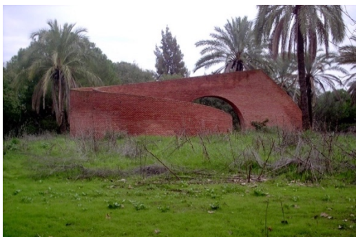
Figura 46.- Estado de conservación del entorno de la obra en 2011. [blog en línea], [consultado el 07/06/2018]. Disponible en: https://arteactualenespaciospublicos.files.wordpress.com/2012/02/no20madejado1.jpg
