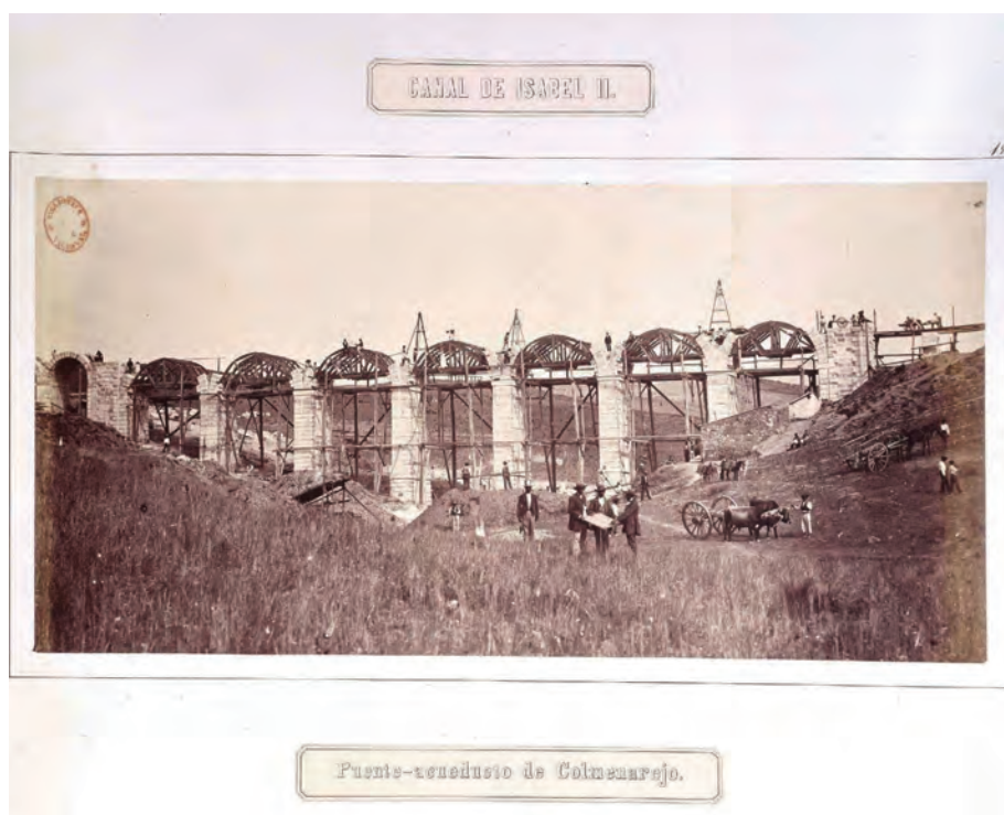
Charles Clifford, «Puente-acueducto de Colmenarejo» (detalle), del álbum Canal de Isabel II , 1856, albúmina. Madrid, Biblioteca Nacional de España.
