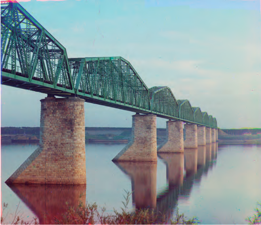
Serguéi Prokudin-Gorski, Puente de hierro con pilares de piedra sobre el río Onda , ca. 1905-1908, color. Washington D.C., Library of Congress.
