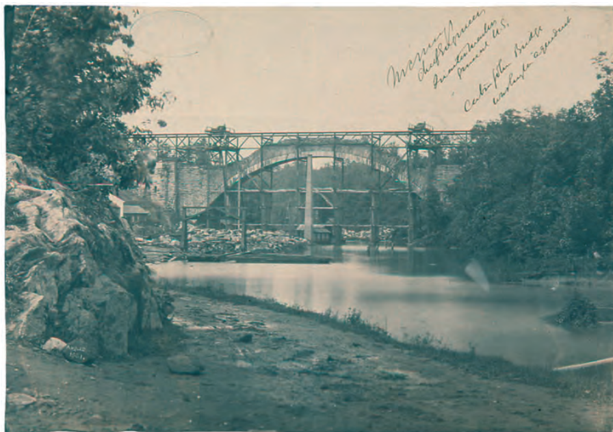
Montgomery C. Meigs, Puente-acueducto de Cabin John tras la elevación de su cimbra, acueducto de Washington , 12 de agosto de 1861, papel a la sal. París, Bibliothèque de l'École nationale des Ponts et Chaussées.
