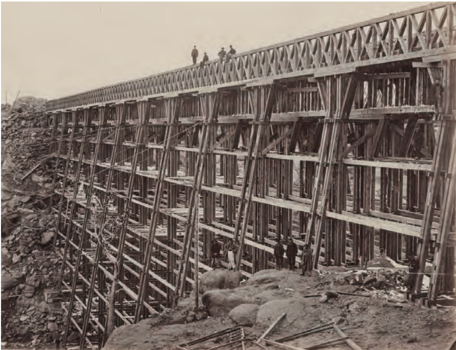
Andrew J. Russel, El puente de Dale Creek , 1868, albúmina. Boston, Public Library.
