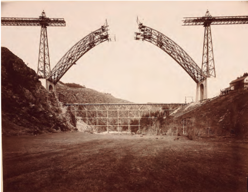
Alphonse Terpereau, «Chantier du viaduc», del álbum Viaducs de Garabit et de La Tardes 1878-1884, albúmina. París, Musée d'Orsay.
