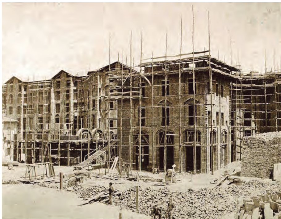
Deroche & Heyland, Galleria Vittorio Emmanuele in costruzione , Milano, 1868, albúmina. Milán, Archivio Storico Civico e Biblioteca Trivulziana.
