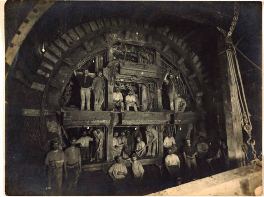
Henry Flather, Construcción de un túnel de la línea District Line por el sistema de cut and cover , 1868, albúmina. Londres, London Transport Museum.
