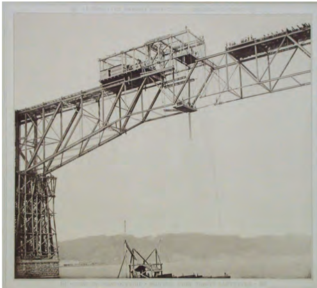
Les Travaux Publics de l'Amérique du Nord. Viaduc de Randolph, 1887-1889, albúmina. Montreal, Centre Canadien d'Architecture.
