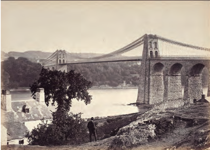
Francis Bedford, Puente de suspensión Menai, Bangor, 1870 , albúmina. Londres, Science Library.
