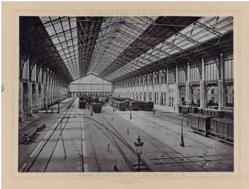
«Chemin de Fer d'Orléans. Gare de Paris», publicado en Les Travaux Publics de la France , Vol. 2, lám. 27. Madrid, Biblioteca Nacional de España.
