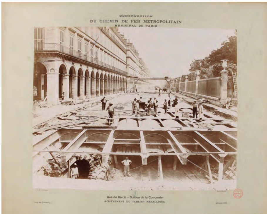
Charles Maindron, Vue de la construction du métro achèvement du tablier métallique rue de Rivoli à la station Concorde. 1er et 8ème arrondissement, albúmina, 1899. París, Musée Carnavalet.
