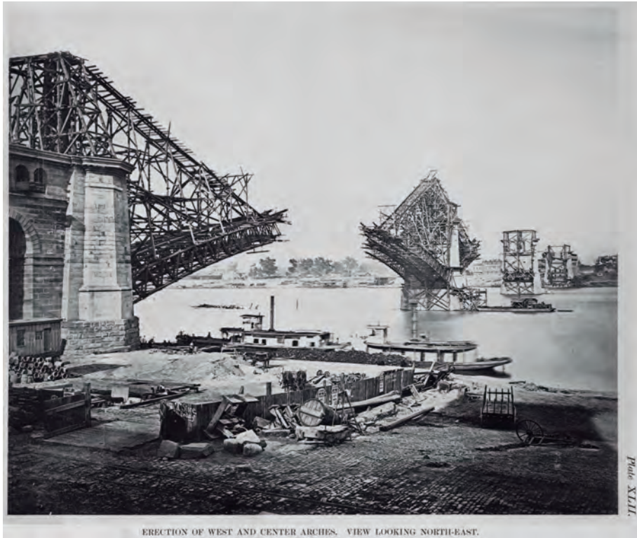
Anónimo, The Eads Bridge over the Mississippi River under construction in St. Louis, Missouri , 1874, albúmina. Colección particular.
