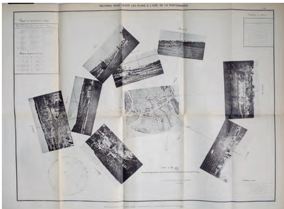
Aimé Laussedat (1898). « Uso de la fotografía para el levantamiento de planos », Recherches sur les instruments: les méthodes et le dessin topographiques . París, Gauthier-Vilars.
