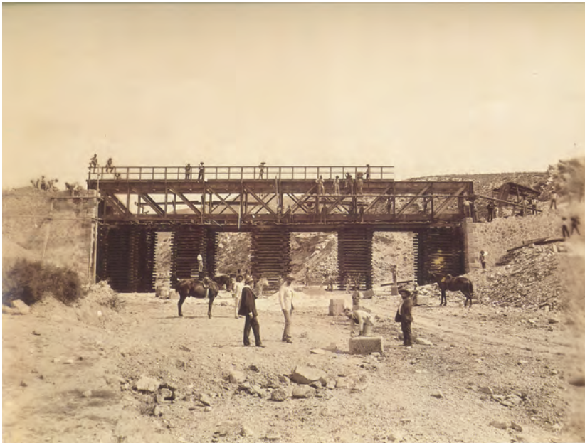
José Rodrigo, Construcción de un puente en la línea de Lorca a Baza , h. 1880, albúmina. Colección particular.
