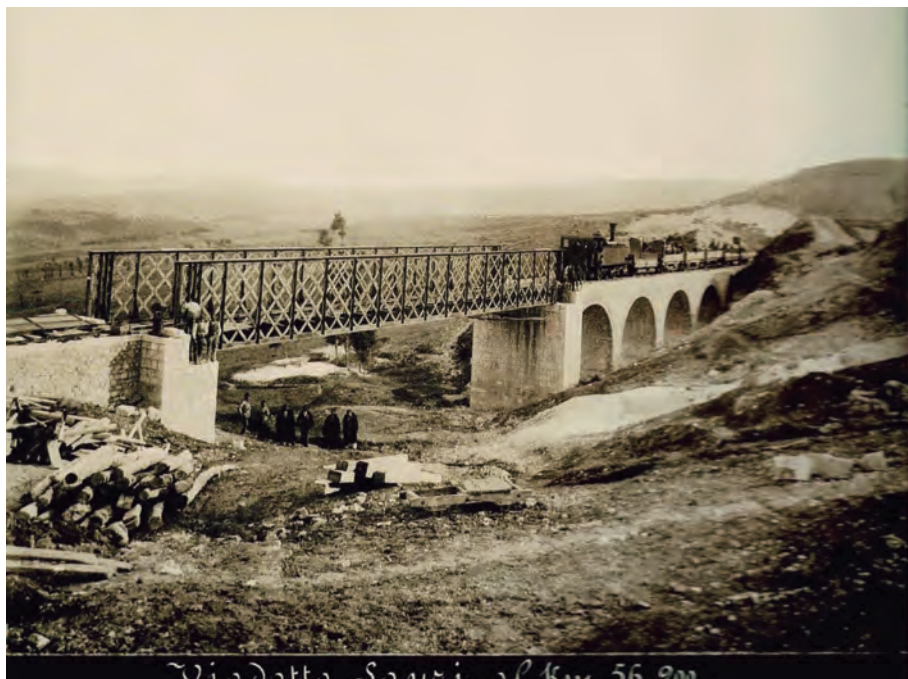
Achille Mauri, Viadotto Sauri a Km. 56,200 , 1867-1873, albúmina. Florencia, Museo Fratelli Alinari.
