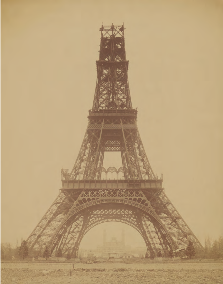
Durandelle & Delmaet, Construction de la Tour Eiffel , 1888, albúmina. París, Bibliothèque nationale de France.
