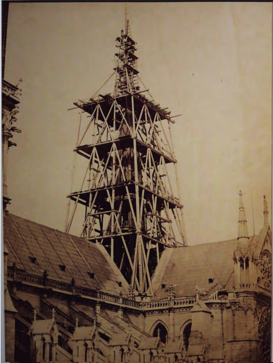
Bisson frères, Échafaudages de la construction de la flèche de la cathédrale Notre-Dame de Paris , 1853, albúmina. Charenton-le-Pont, Médiathèque de l'architecture et du patrimoine.
