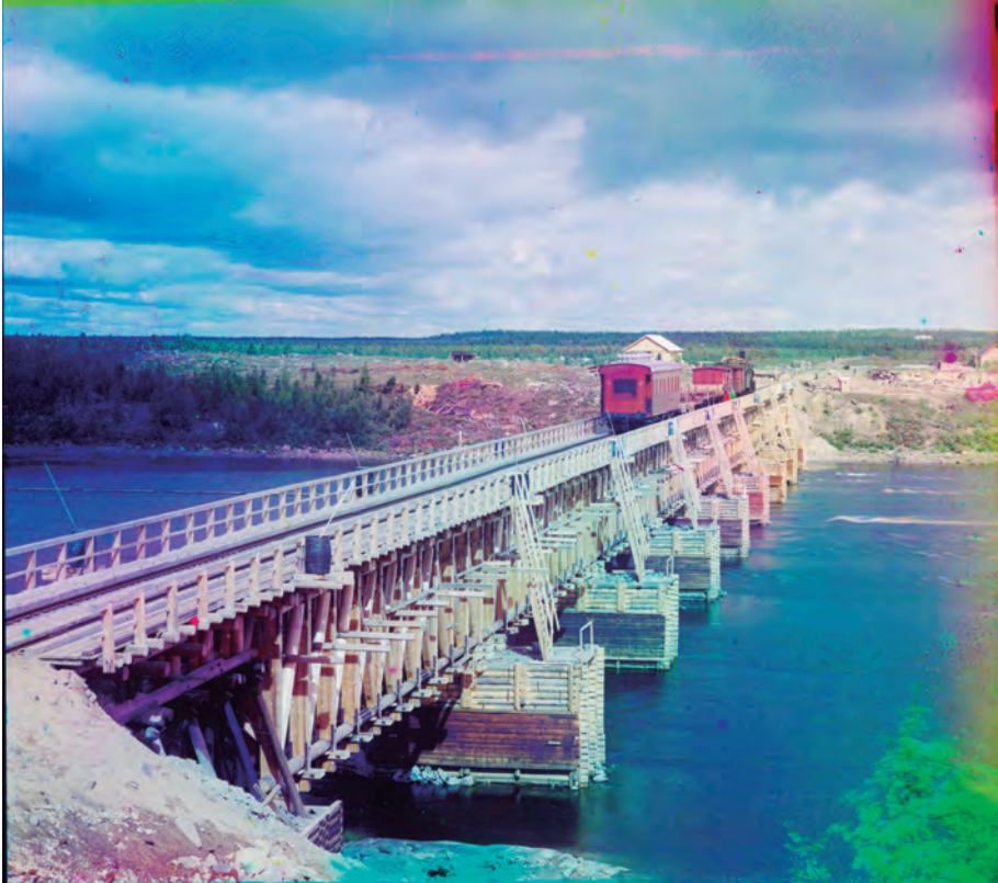
Serguéi Prokudin-Gorski, Vista de un puente de caballete en la línea del Transiberiano , ca. 1905-1908, color. Washington D.C., Library of Congress.
