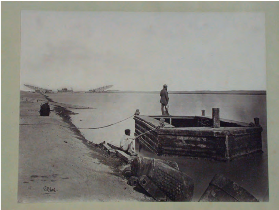
Frank Mason Good, Gran Canal de Suez . Al fondo el Mar Rojo, copia al carbón. Montreal, Centre Canadien d'Architecture.
