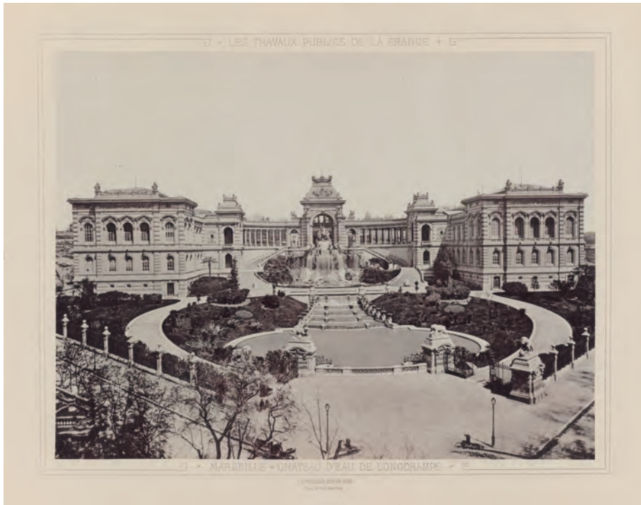
Adolphe Terris, Marseille , «Castillo de Agua de Longchamps», del álbum Les Travaux Publics de la France , albúmina, [1876]-1883. Madrid, Biblioteca Nacional de España.
