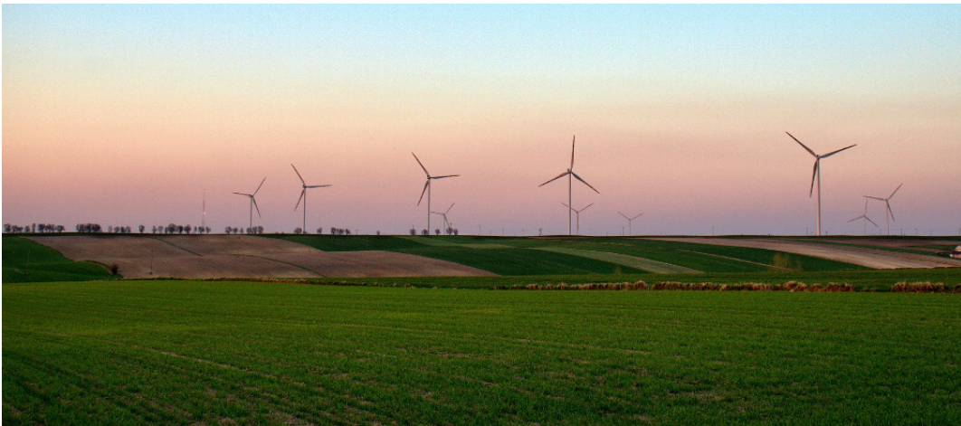
Figura 7.13: Paisaje de un parque eólico descargado de https://pixabay.com/es/photos/renovables-molinos-de-viento-energía-4157213/ .
