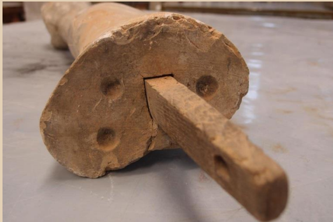
Antinoo Osiris: ensamble del brazo al hombre mediante “pasador” de madera
