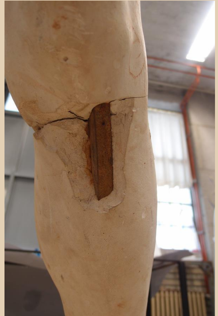
Estructura metálica de sección cuadrada
