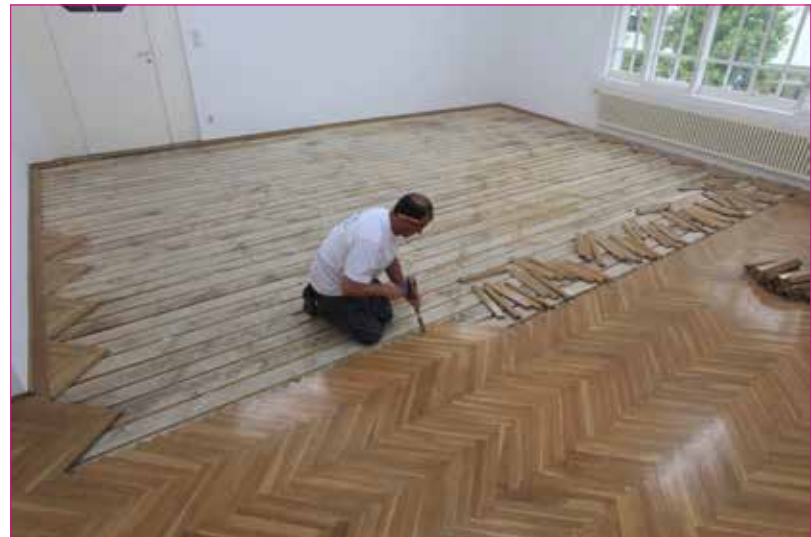
Retirar el suelo de parket de la sala de exposiciones, (Secesión, Viena,) 2010
